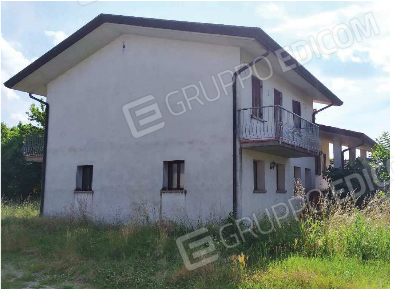
Veduta esterna dell'abitazione
