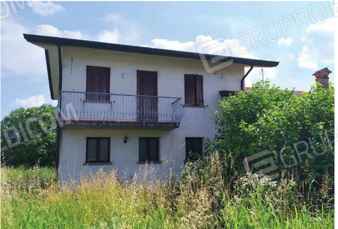
Veduta esterna dell'abitazione
