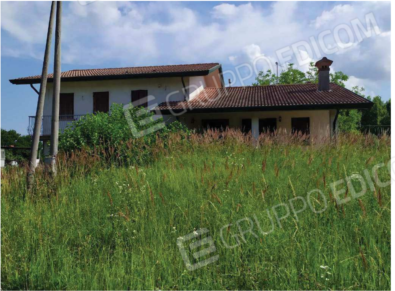
Veduta esterna dell'abitazione
