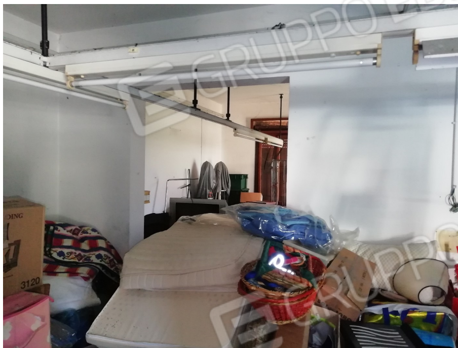
Foto 3 – locale piano terra
