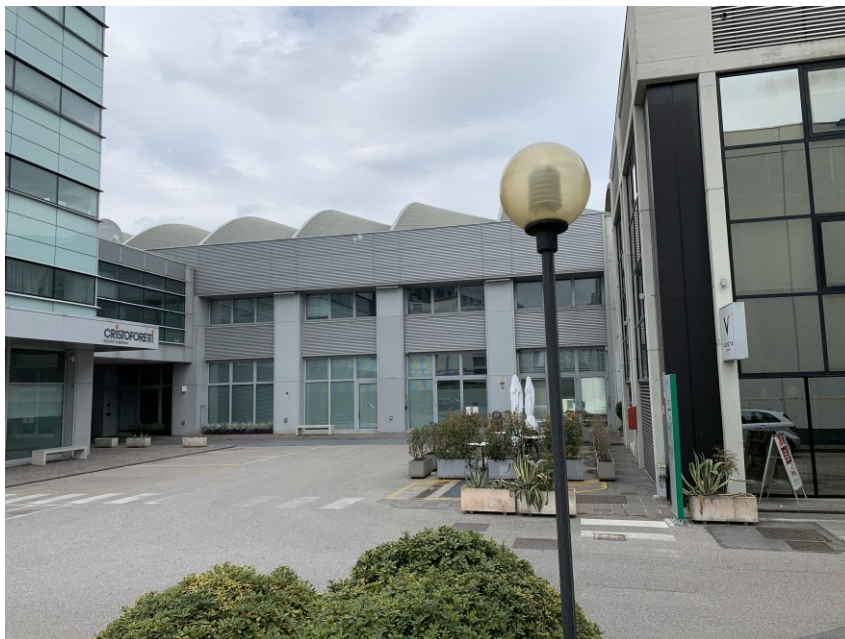
Scorcio con la vista sud di porzione del Blocco "Loft" in via Nona Strada n. 23 a Padova
