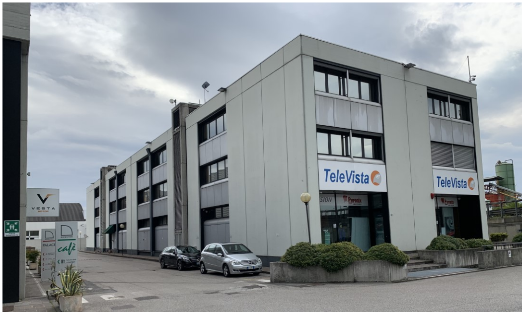
Complesso "Bicenter" – Blocco B "Beta" in via Nona Strada n. 23 a Padova | coordinate Google 45°24'55.1"N 11°55'58.4"E
