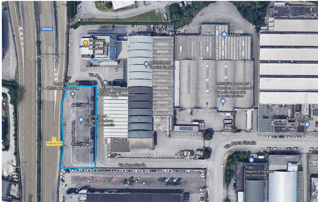
Blocco B "Beta" in via Nona Strada n. 23 a Padova
