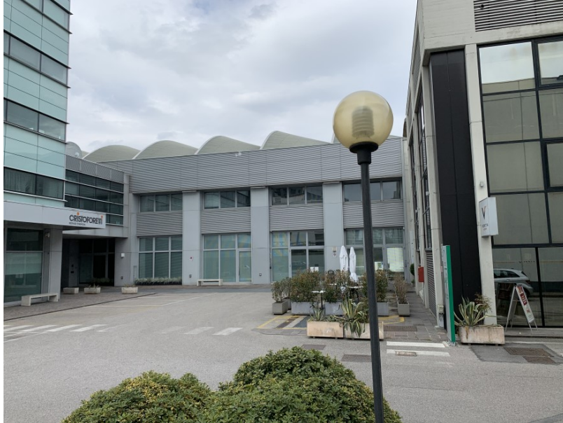
Complesso "Bicenter" – Blocco A "loft – Palace" in via Nona Strada n. 23 a Padova | coordinate Google 45°24'55.1"N 11°55'58.4"E
