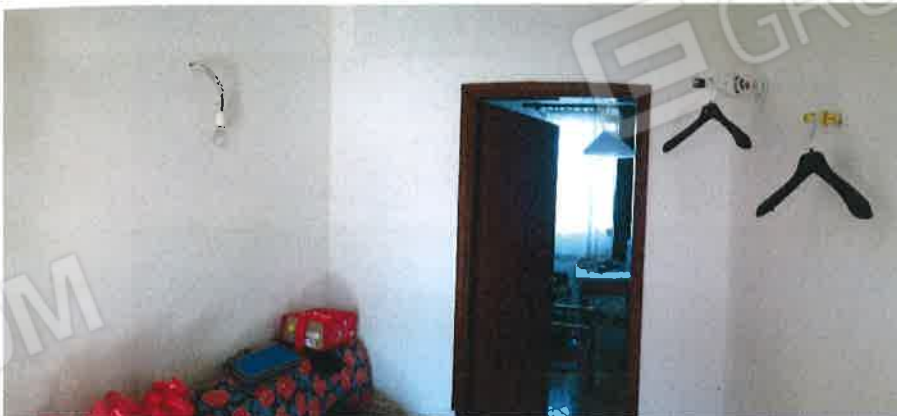
Appartamento in difformità PT - ingresso
