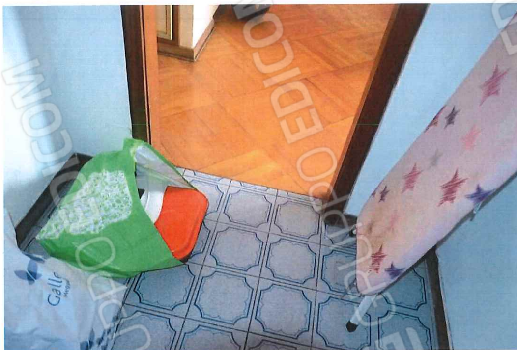
21. particolare pavimenti disimpegno cucina e soggiorno-pranzo
