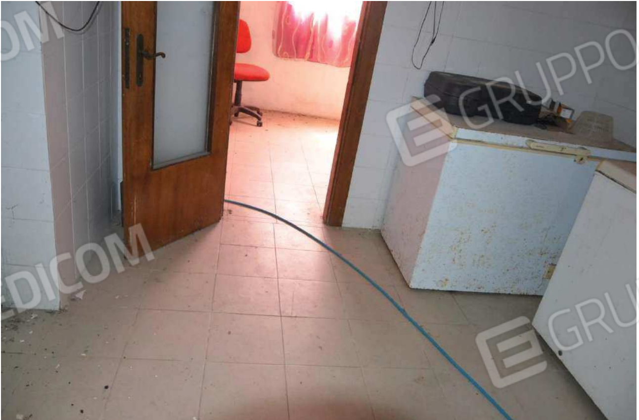
Locali dispensa e spogliatoio
