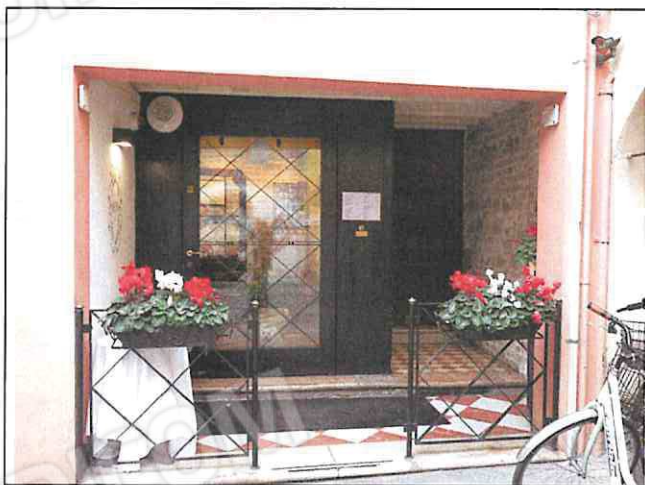
Foto n°6: loggiato di accesso
