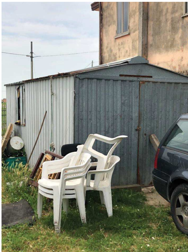
Figura 14 – Baracca in lamiera eretta abusivamente sul cortile ad uso esclusivo
