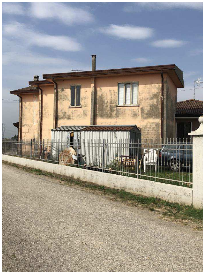
Figura 11 – Facciata nord-est del fabbricato
