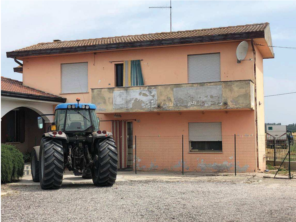
Figura 10 – Facciata sud-ovest del fabbricato
