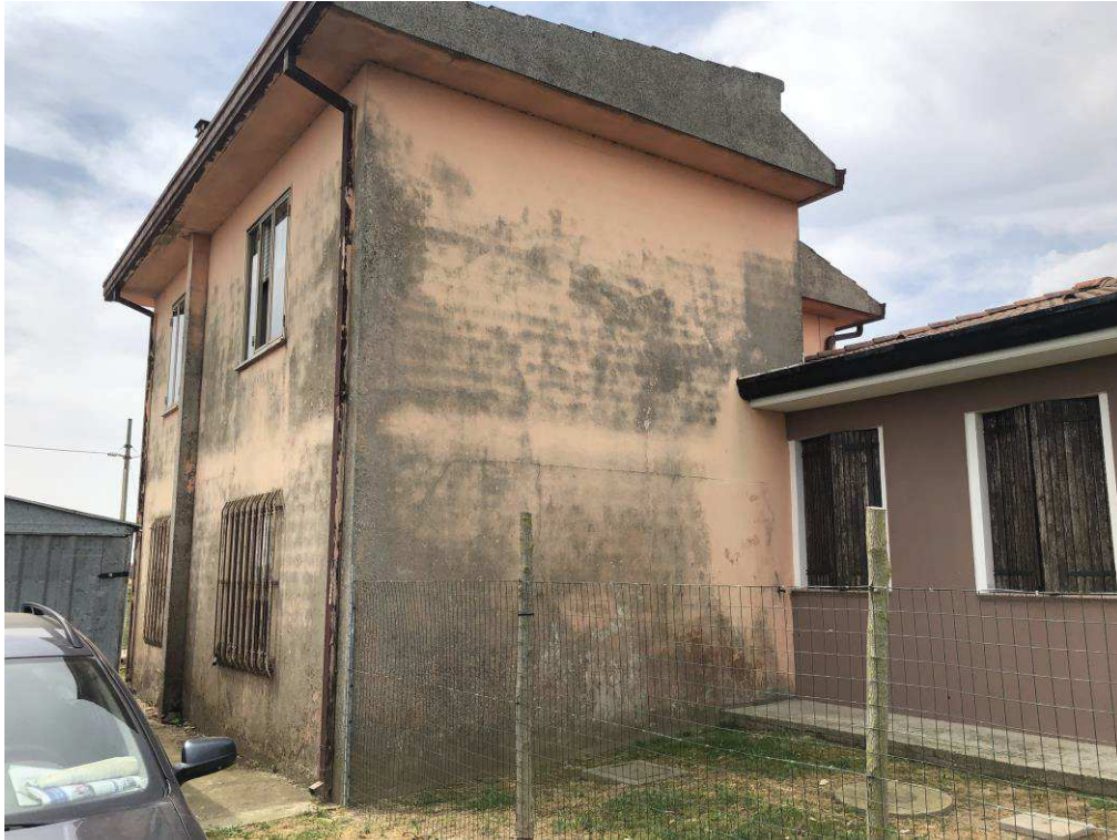
Figura 12 – Facciata nord-ovest del fabbricato
