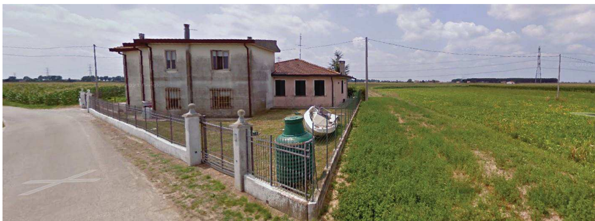
Figura 18 - recinzione su via San Rocco (tratto da Google Maps, stato del 2011)
