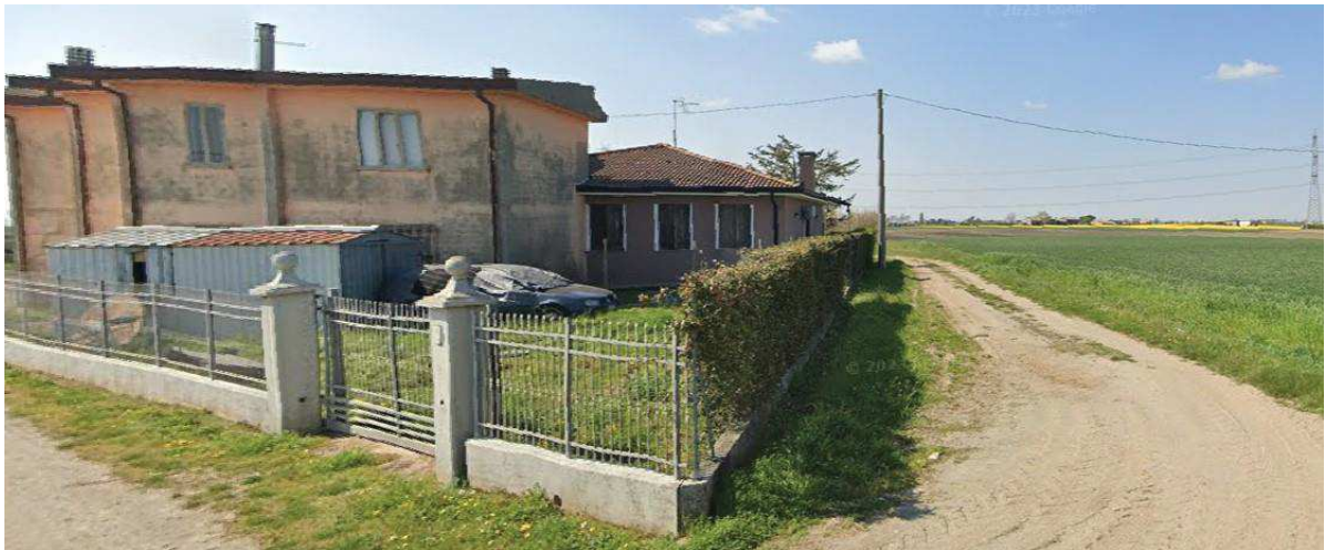
Figura 17 - recinzione su via San Rocco (tratto da Google Maps, stato del 2023)
