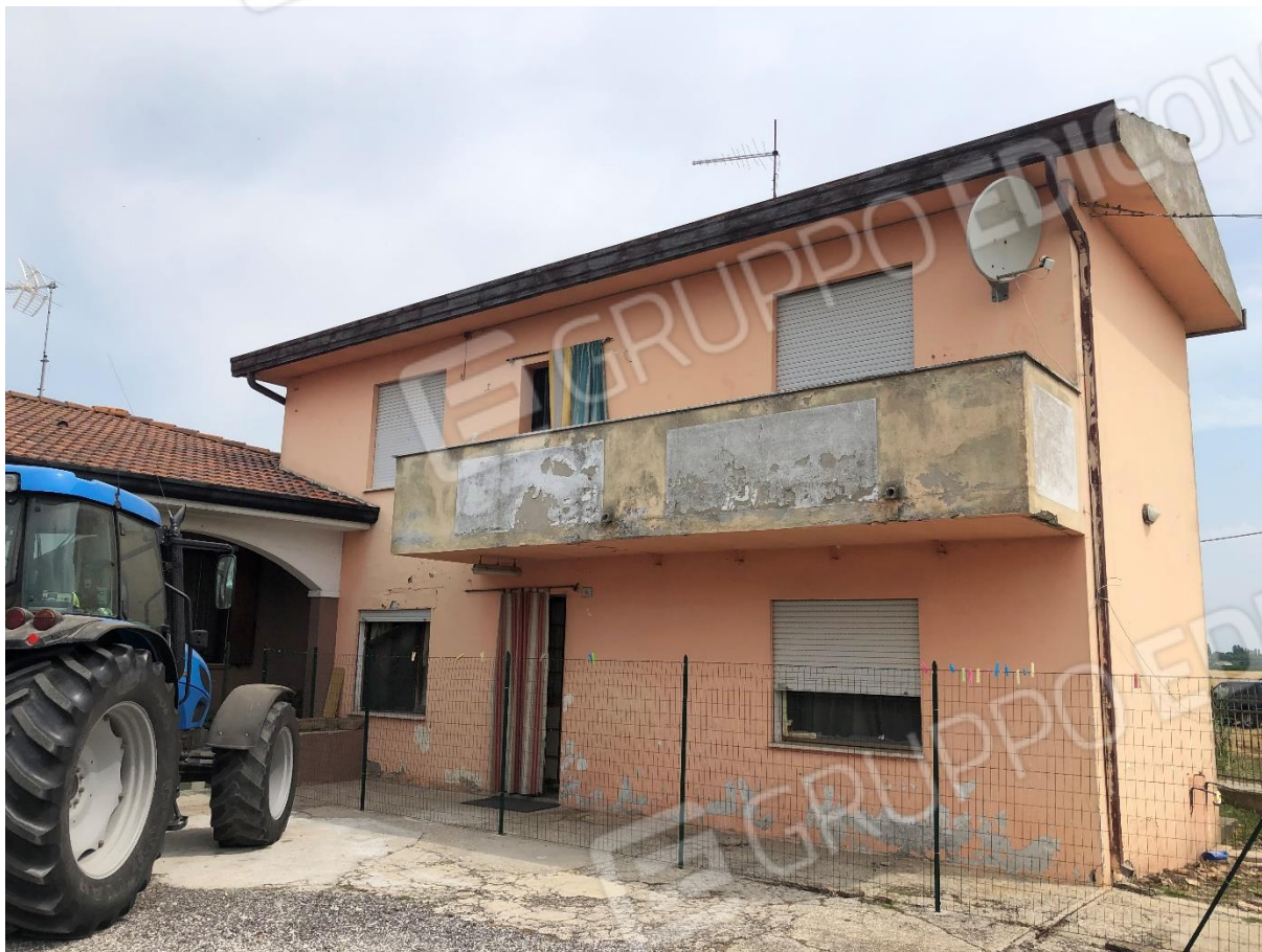
foto n. 3 – facciata sud-ovest del fabbricato
