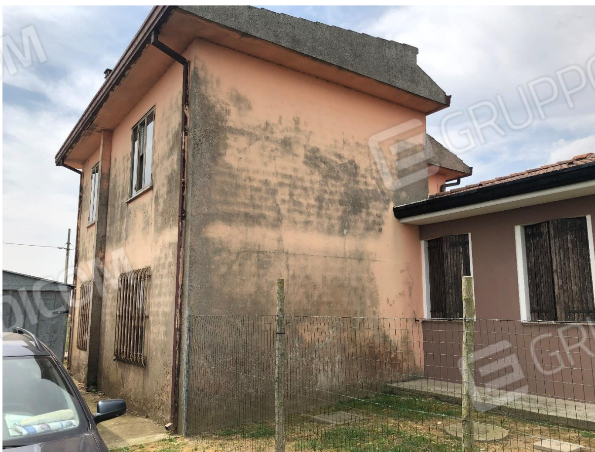
foto n. 4 – facciata nord-ovest fabbricato
