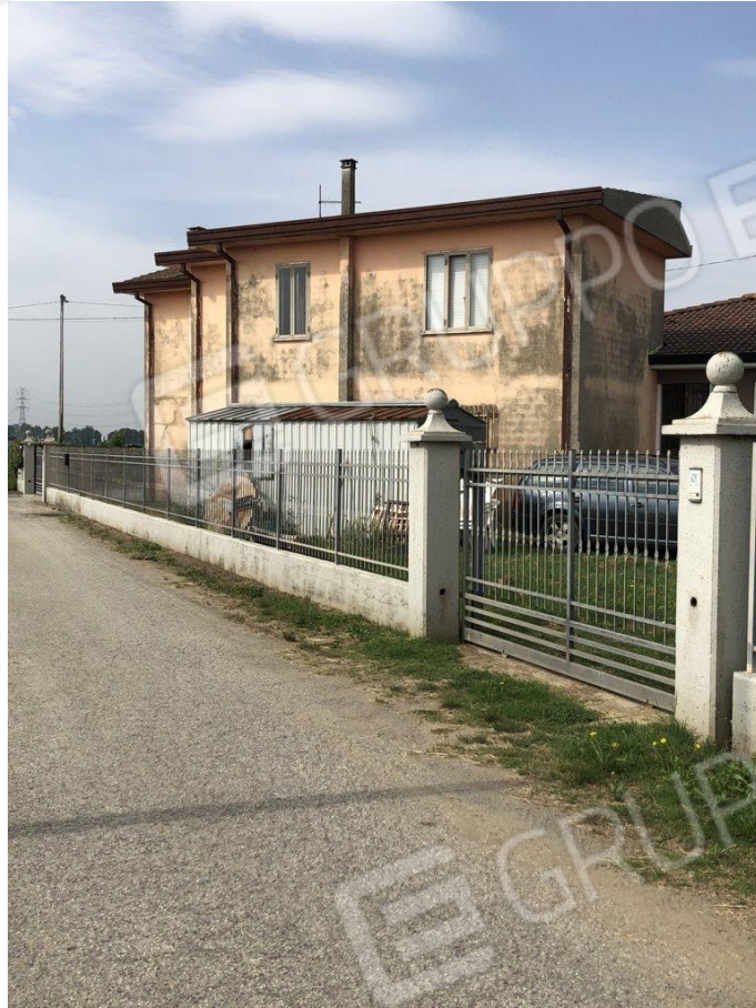
foto n. 1 – facciata nord-est del fabbricato
