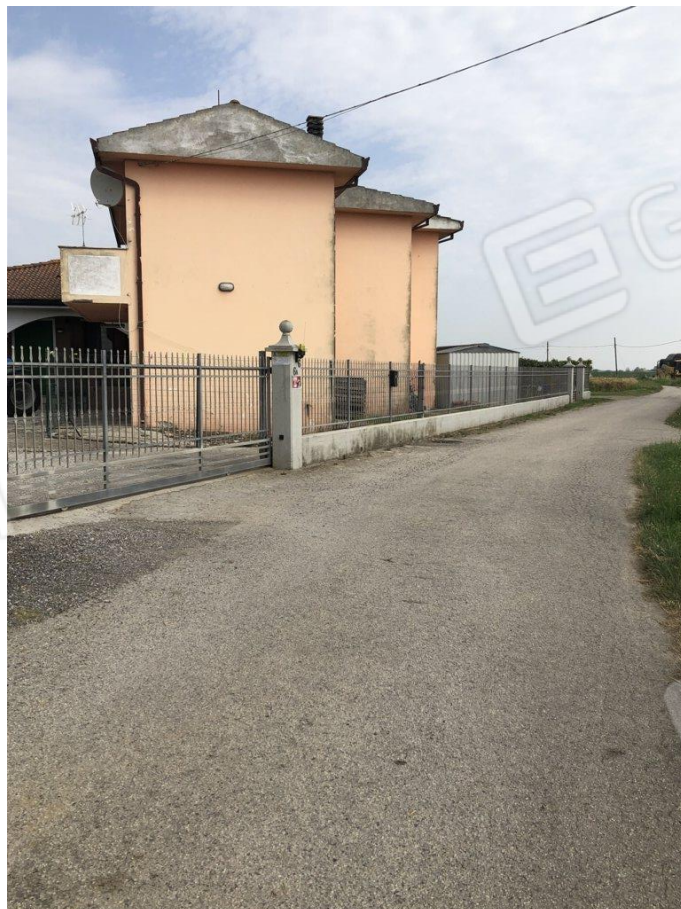
foto n. 2 – angolo sud-ovest del fabbricato
