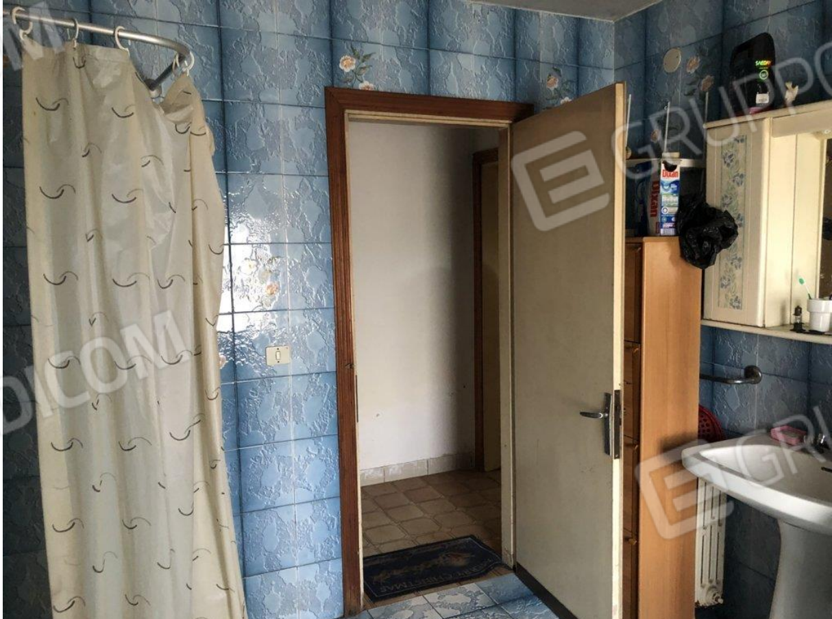
foto n. 14 – bagno a piano terra
