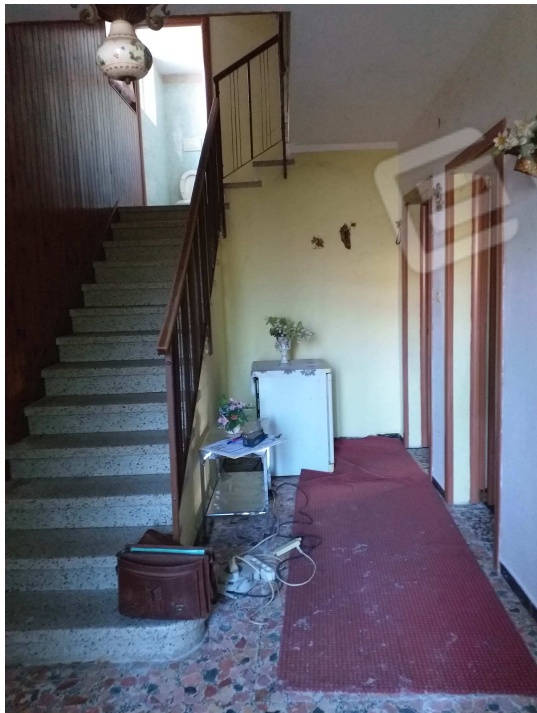
Foto 1 - Ingresso lato ovest
