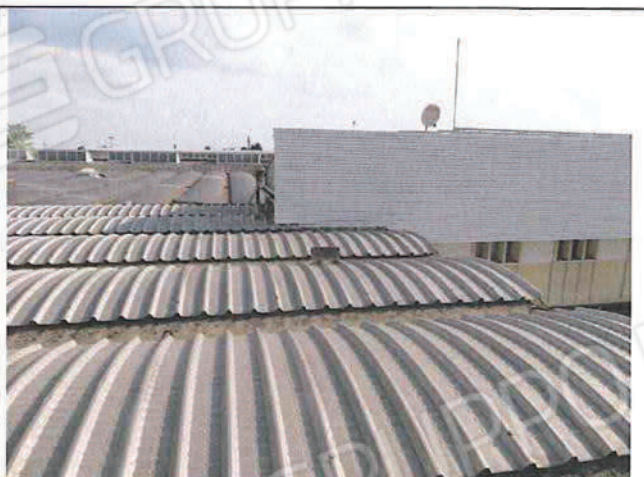
Foto n°202: Coperture sei capannoni sub 6
