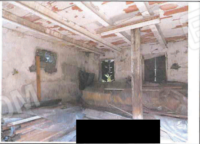
Foto n°239: Interni del sub 2 al P.T.
