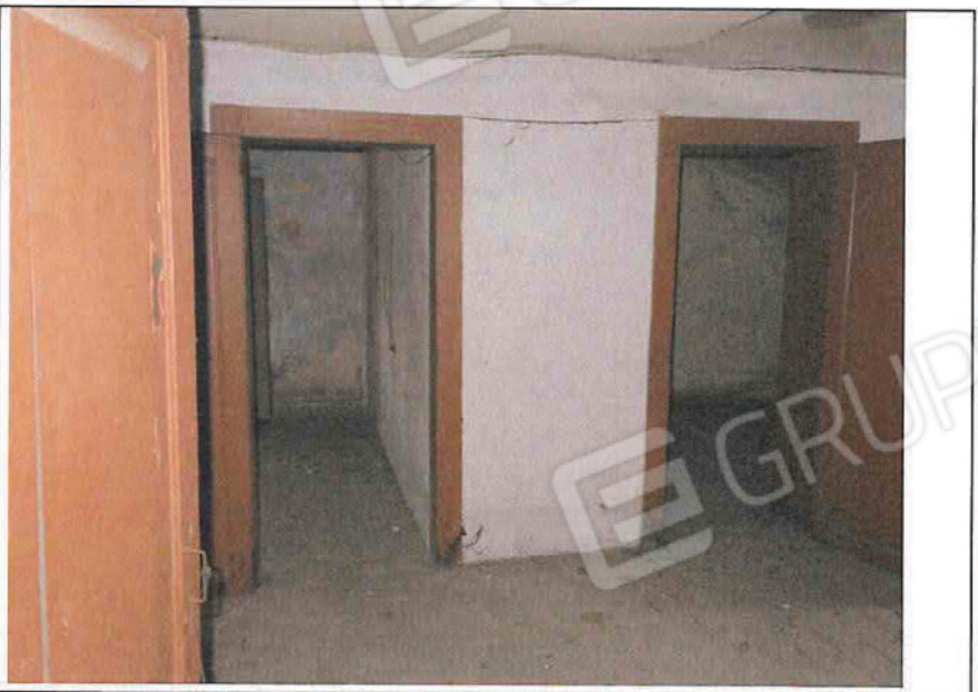
Foto n°242: Interni del sub 2 al P.1° fronte strada.
