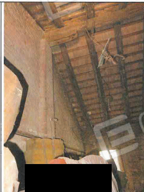
Foto n°236: Interni del sub 2 al P.1°
