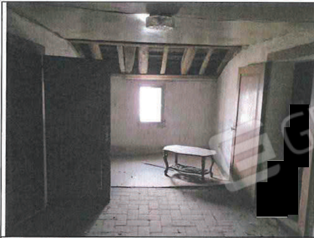
Foto n°243: Interni del sub 2 al P.1° fronte strada.
