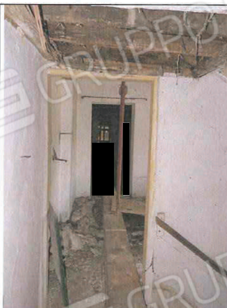
Foto n°246: Interni del sub 2 al P.1° fronte strada.
