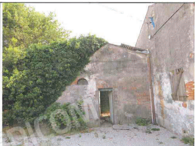
Foto n°217: Fronte nord est
