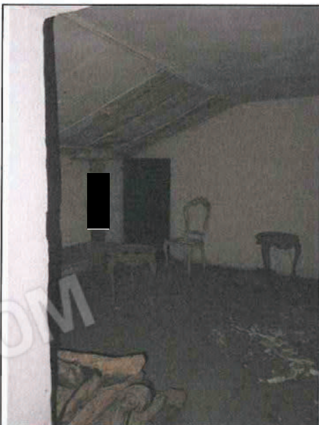
Foto n°245: Interni del sub 2 al P.1° fronte strada.
