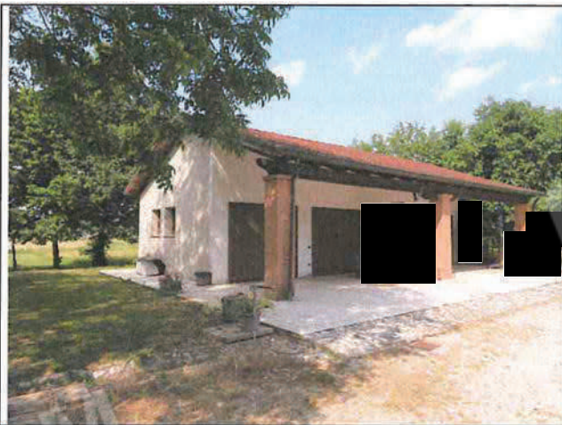
Foto n°7: Fronte sud annesso rustico
