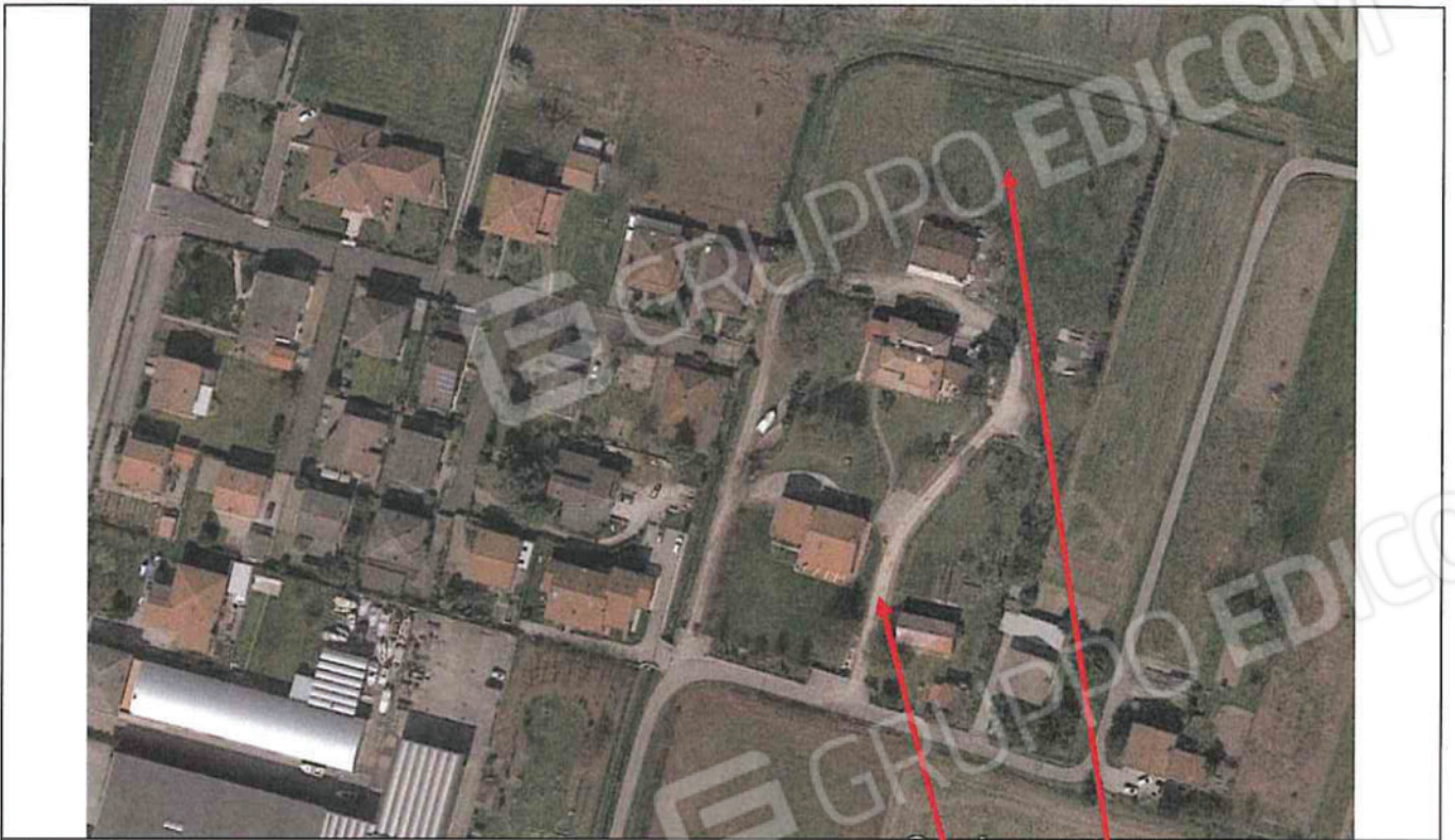
Foto n°3: Foto aerea di inquadramento di maggior dettaglio: mapp 660 e mapp. 853
