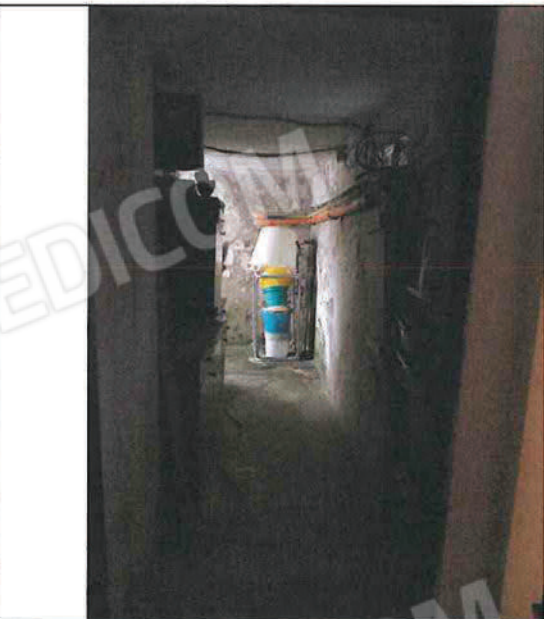
Foto n°33: Cavedio a sud-ovest
