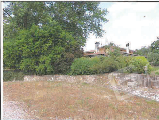
Foto n°11: percorso carrabile ad ovest
