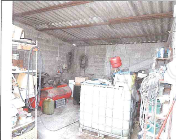
Foto n°87: Interno locale sgombero
