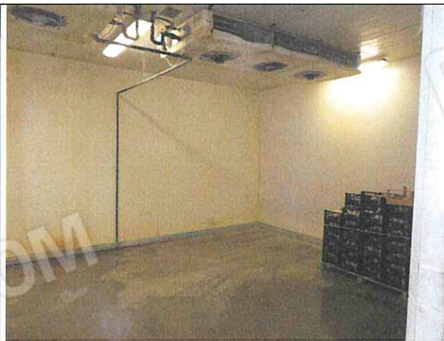
Foto n°136: Interno cella frigo
