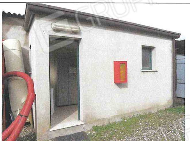
Foto n°63: Piccolo edificio servizi igienici
