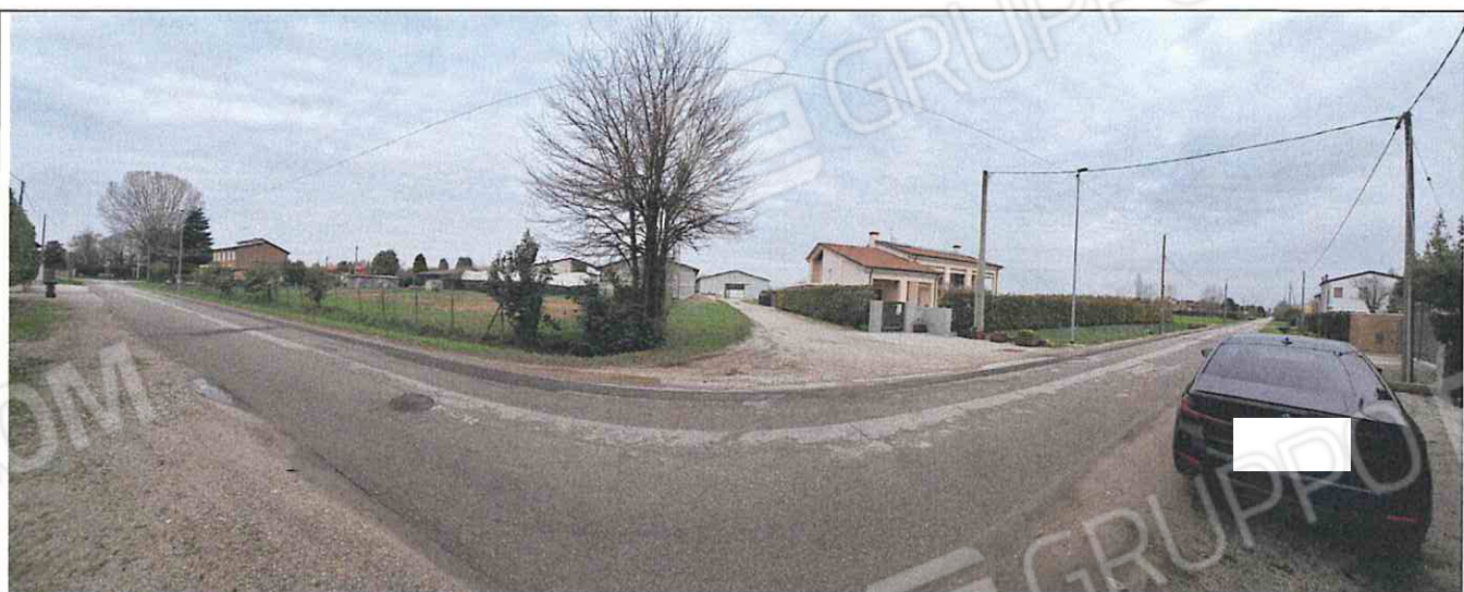
Foto n°163: Vista ingresso mapp. 1003 da via Lusore
