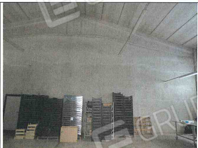
Foto n°139: Interno ricovero prodotti agricoli
