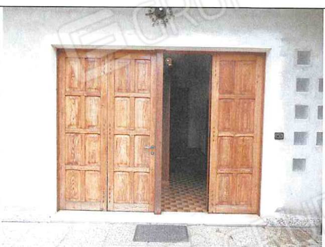
Foto n°17: Ingresso al locale sgombero
