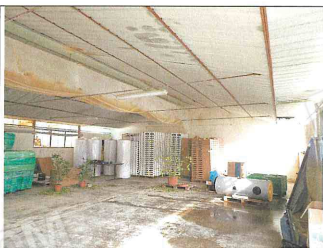
Foto n°48: Fungaia a nord
