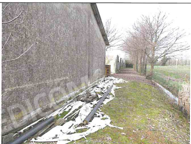
Foto n°44: Prospetto nord, vista estremità mapp. 140
