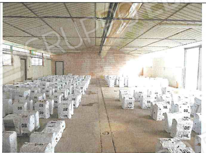
Foto n°61: Vista verso nord
