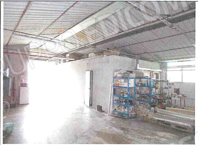
Foto n°77: Vista edificio uffici e servizio igienico interno
