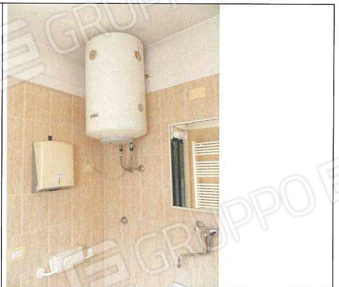
Foto n°67: Scaldabagno
