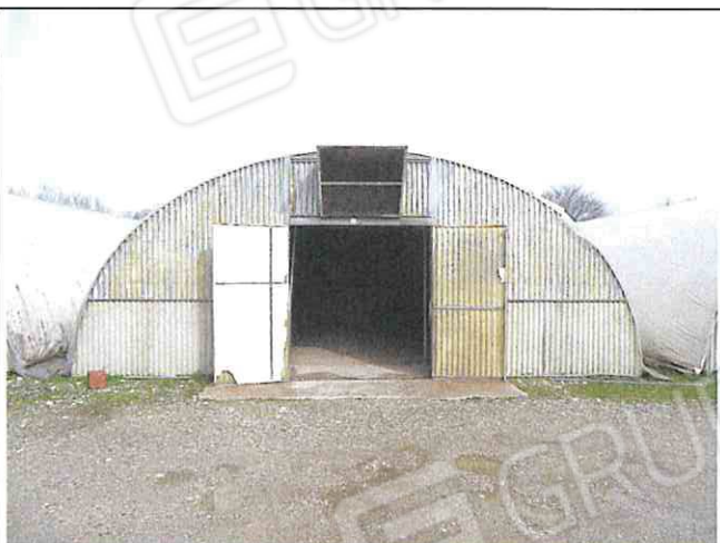
Foto n°173: Ingresso tipo a serra
