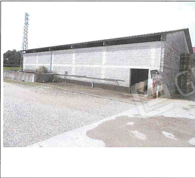
Foto n°122: Vista est edificio E
