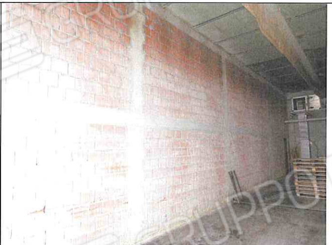
Foto n°149: Murature divisorie camera di incubazione
