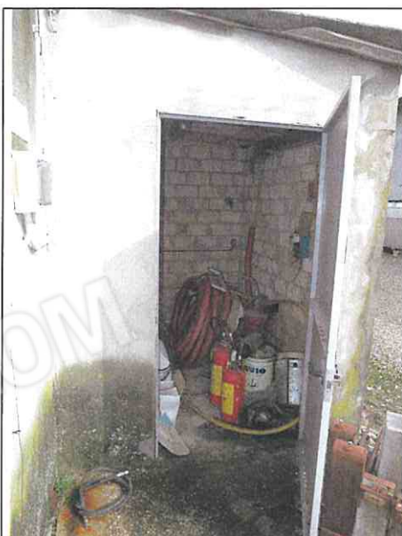
Foto n°72: Accesso allo ripostiglio a sud-est
