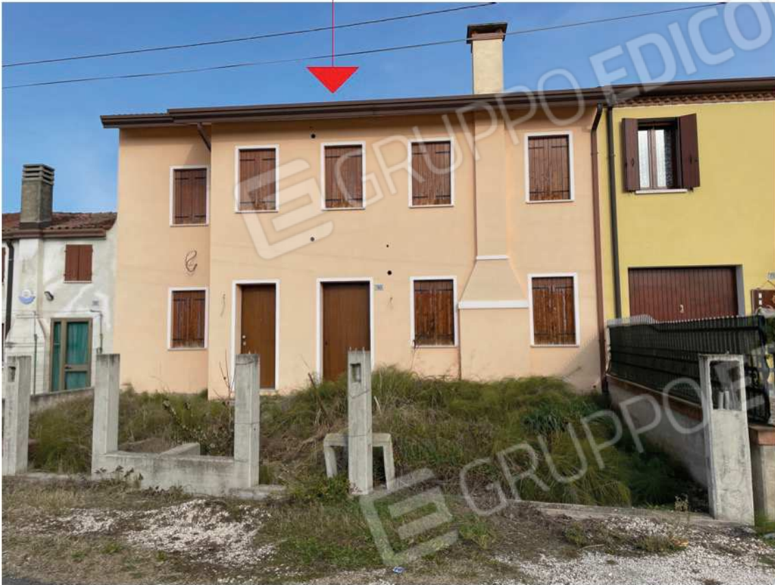
4 - Vista lato sud
