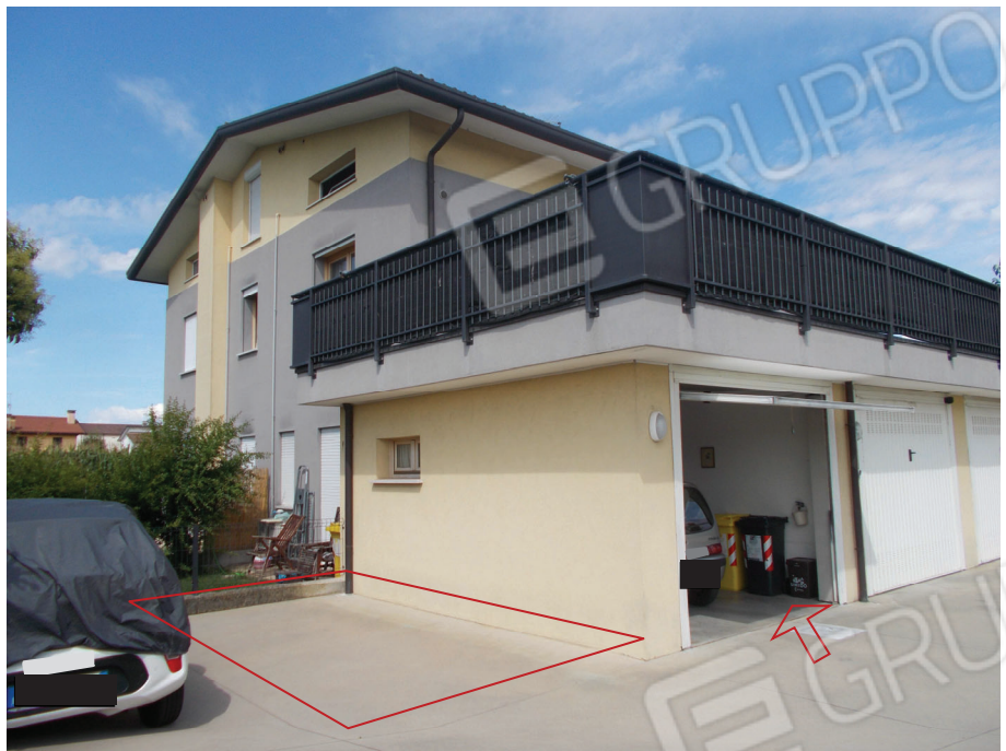
Foto 4- LOTTO 1- Vista da sud est -garage e posto auto
