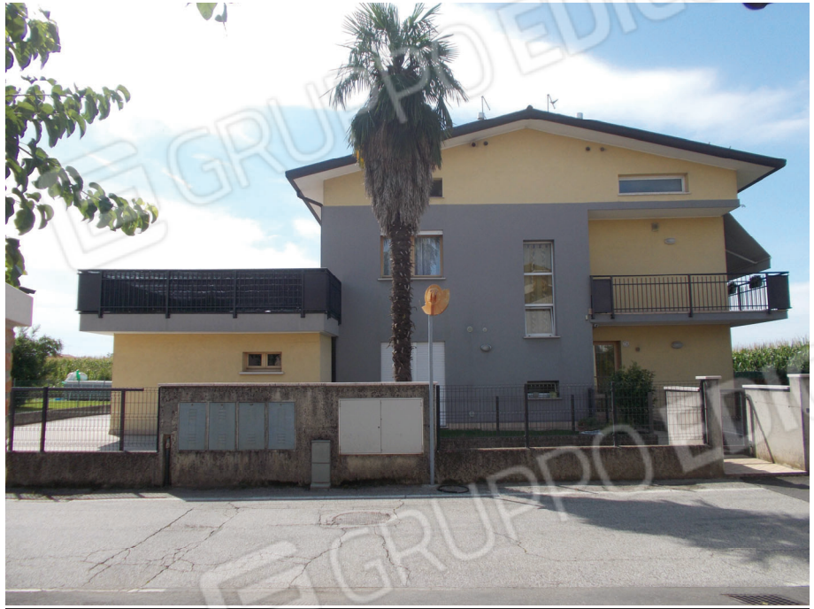
Foto 3- LOTTO 1- Vista da nord fronte strada
