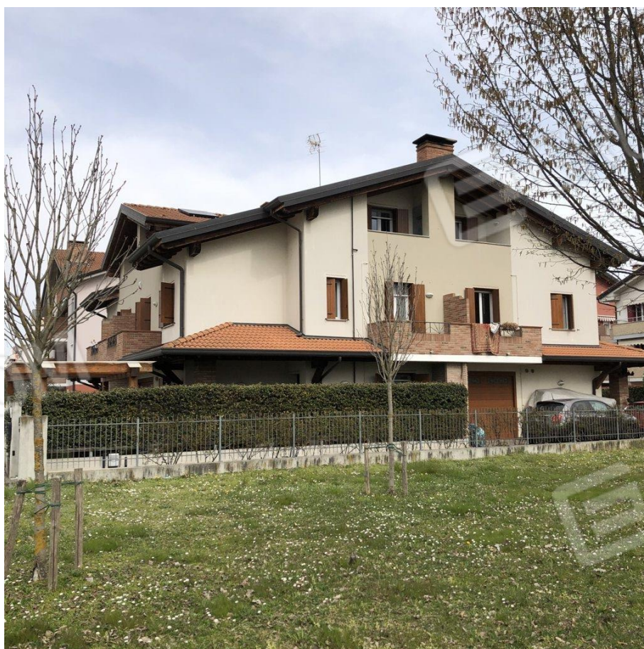
foto n. 2 – facciata sud del fabbricato
