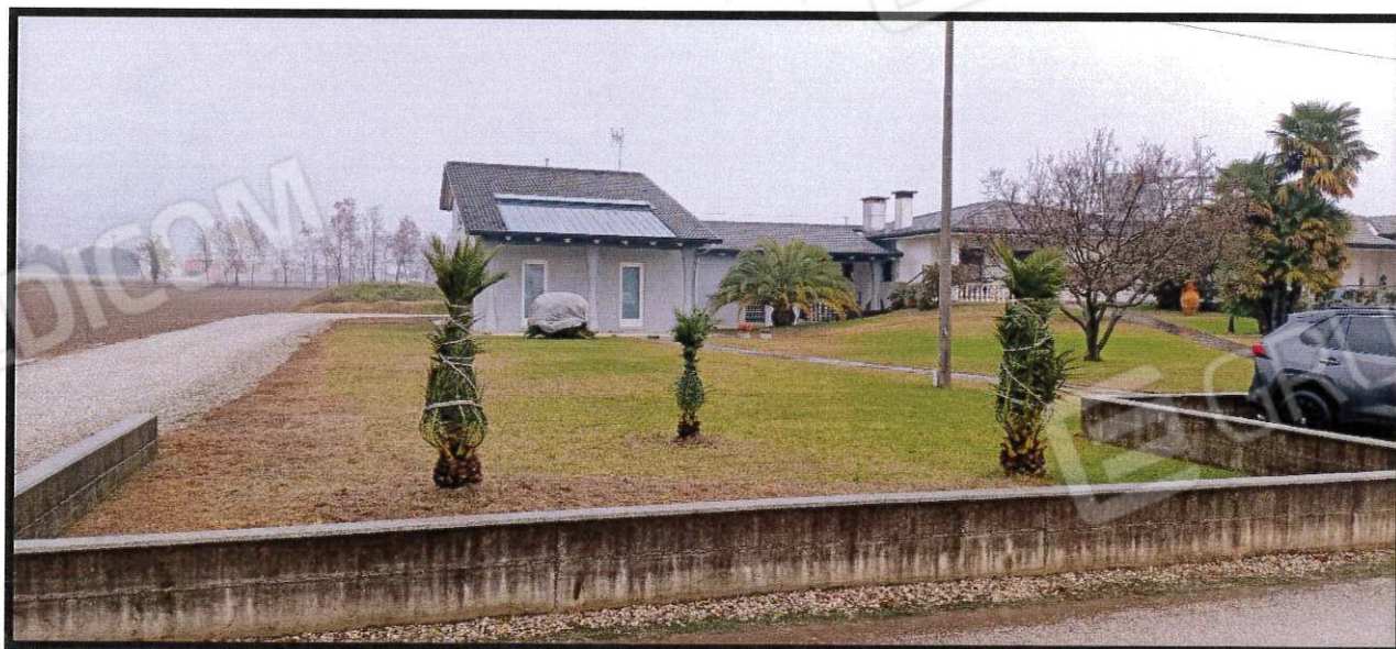
Foto n. 3: Vista abitazione, prospetto SUD.
