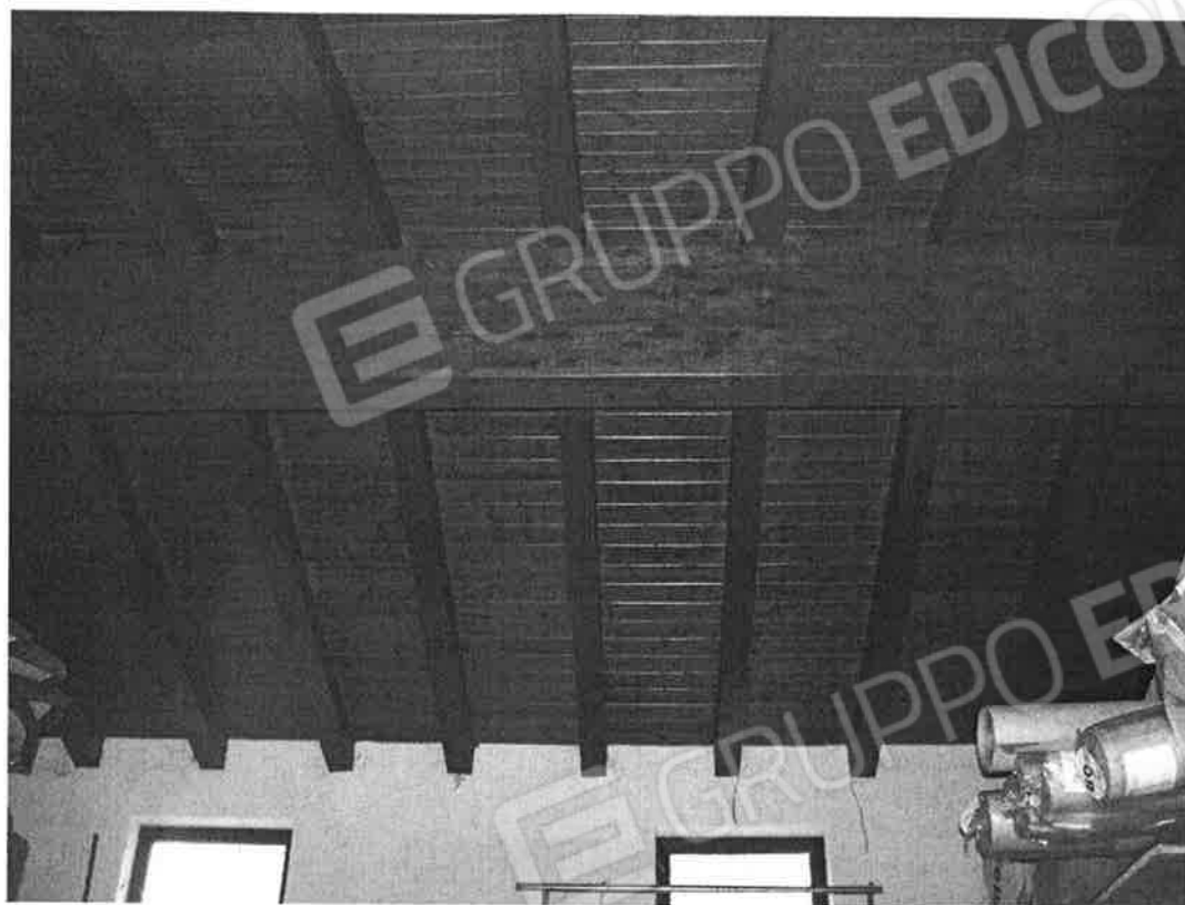
35. La copertura del magazzino
