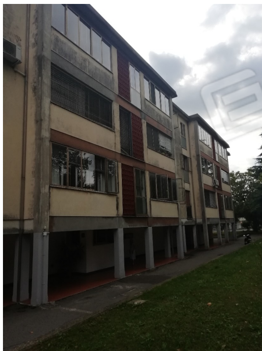
Foto 2: vista condominio fronte
