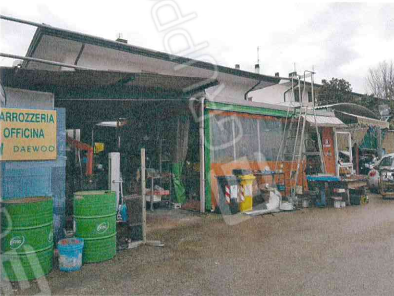
vista esterna dal cortile comune
