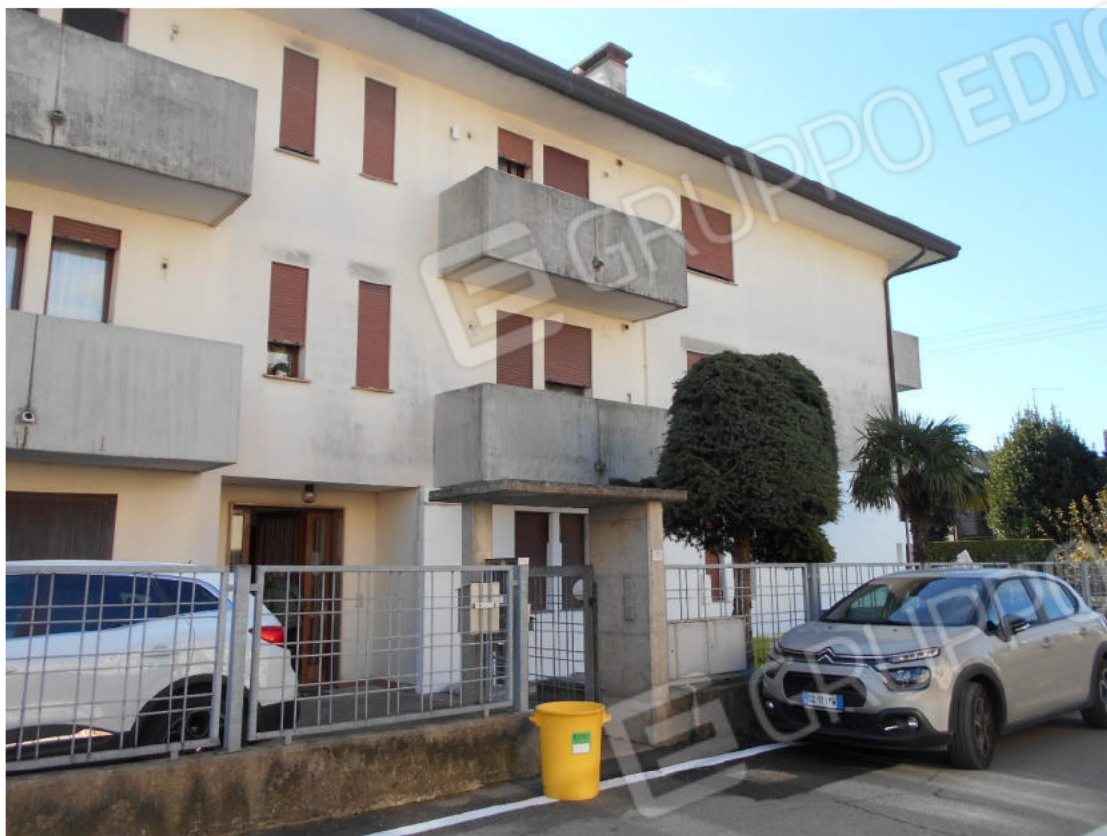
Foto 2: fabbricato condominiale, vista da nord (via Papa Giovanni XIII), ingresso pedonale
