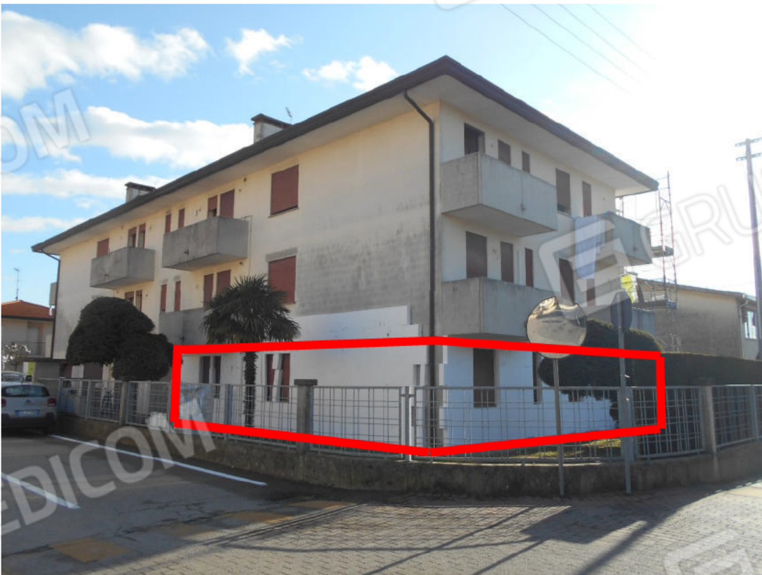
Foto 1: fabbricato condominiale di cui i beni fanno parte, vista da via papa Giovanni XXIII, angolo nord-ovest. Riquadrata in rosso la porzione in oggetto (appartamento)
