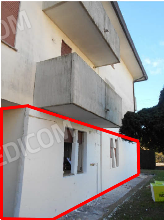
Foto 5: particolare prospetto nord dell'edificio. Riquadrata in rosso la porzione in oggetto (appartamento)
