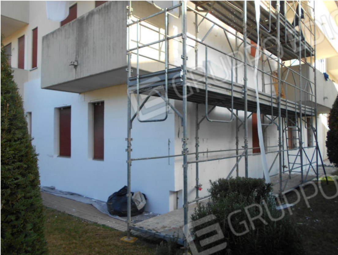
Foto 8: cortile condominiale angolo sud-ovest
