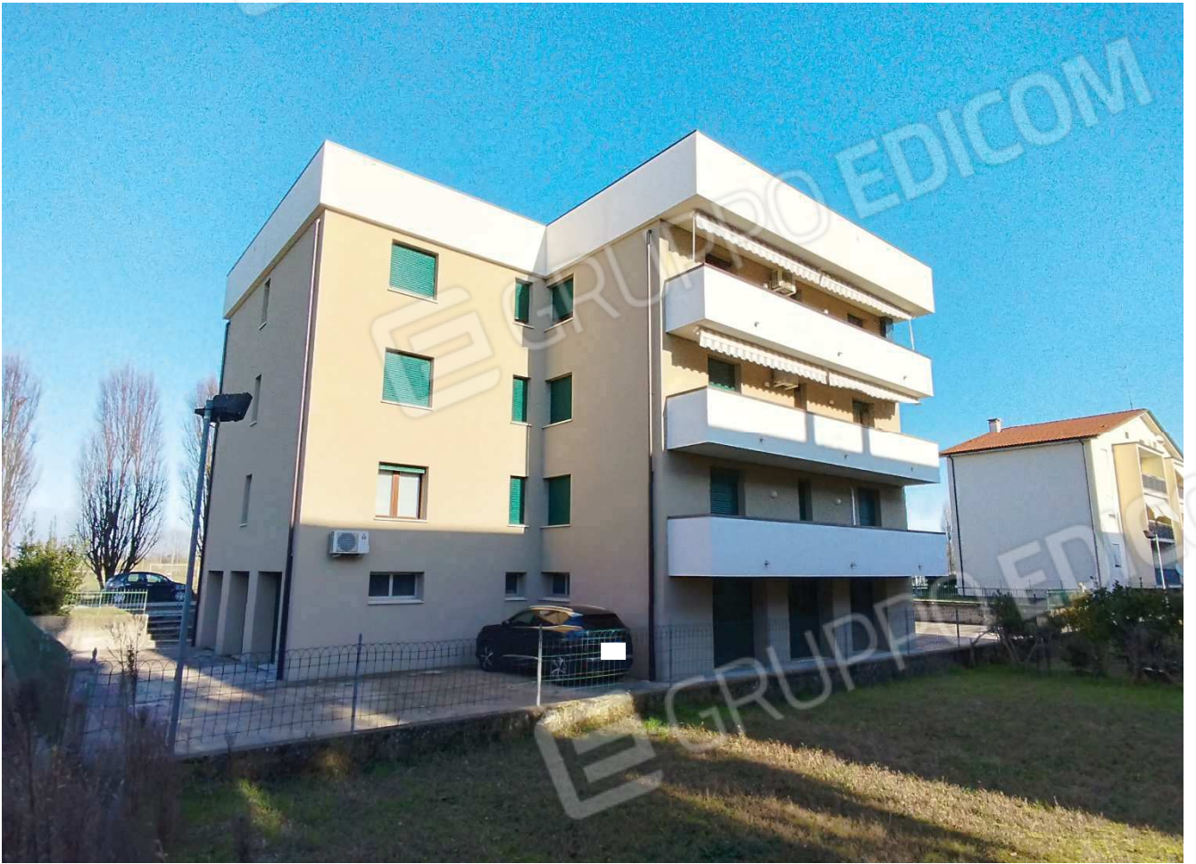
Veduta esterna del fabbricato condominiale
