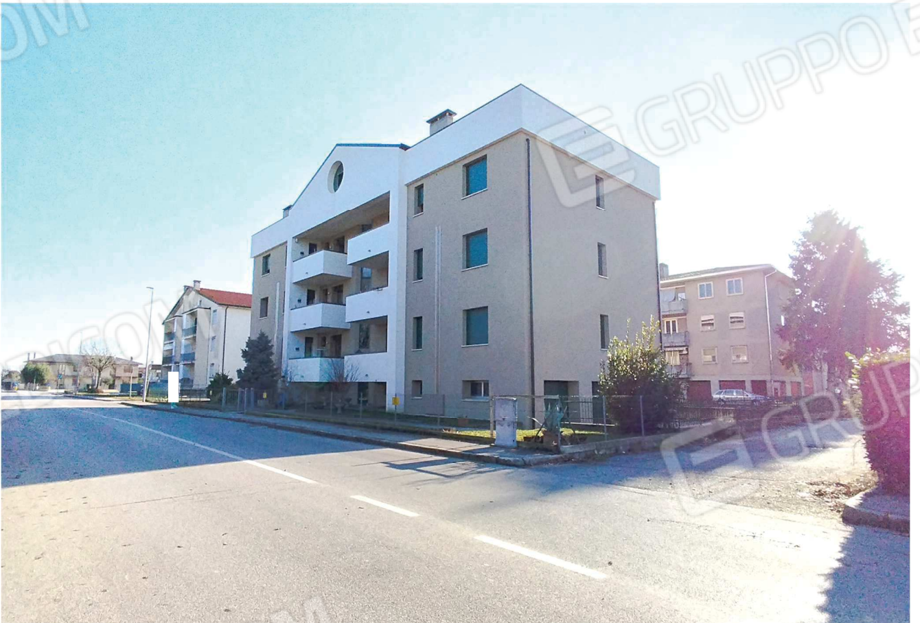
Veduta esterna del fabbricato condominiale
