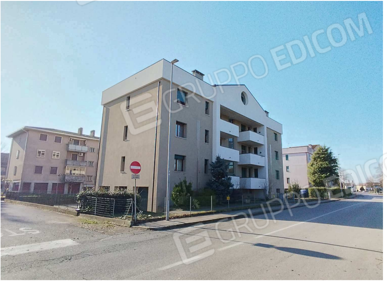
Veduta esterna del fabbricato condominiale
