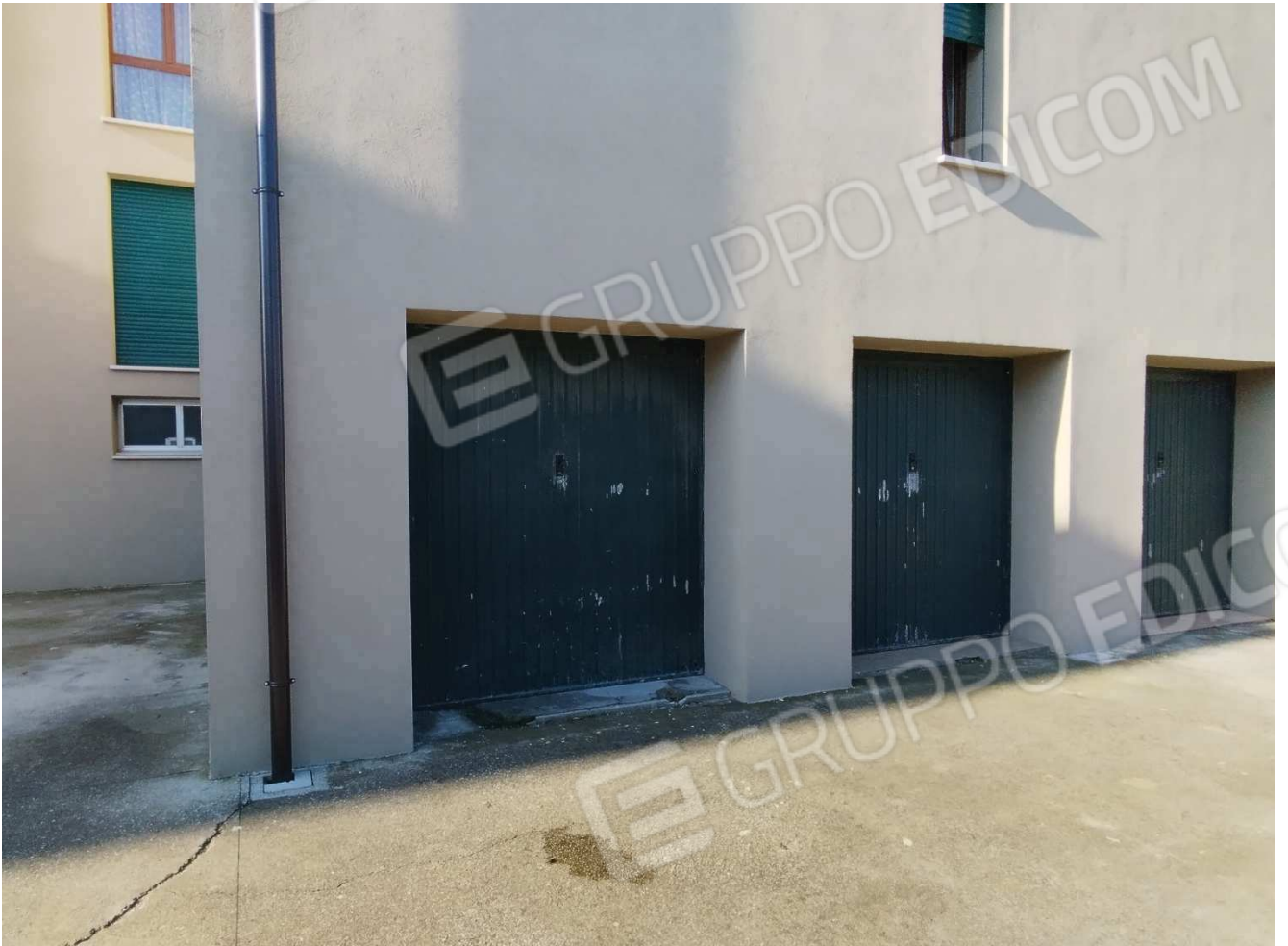
Scoperto condominiale verso i garage
