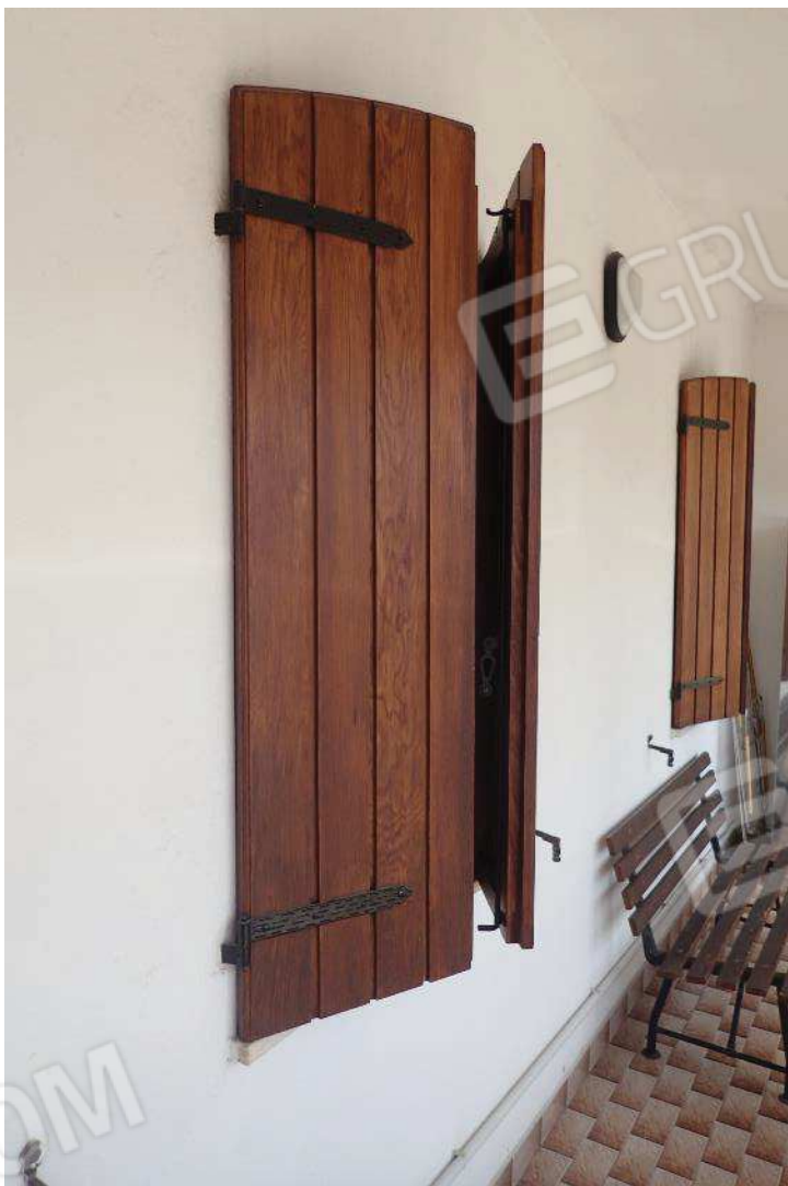
Foto 31 - Particolare infissi esterni
