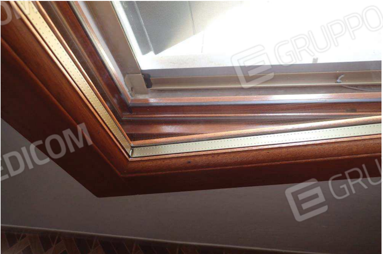
Foto 30 - Particolare infissi interni
