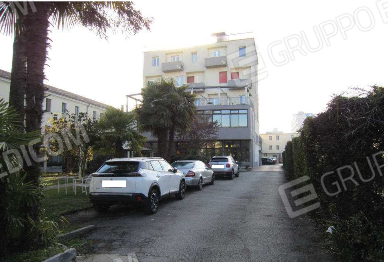
Veduta dell'ingresso carrabile verso l'hotel
