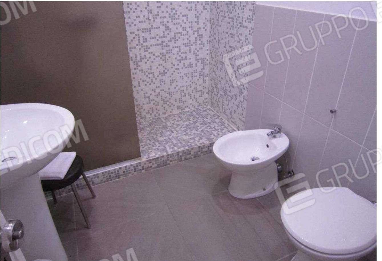
Esempio di bagno
