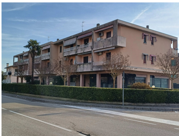
Prospetto nord su via M. Pasubio.
