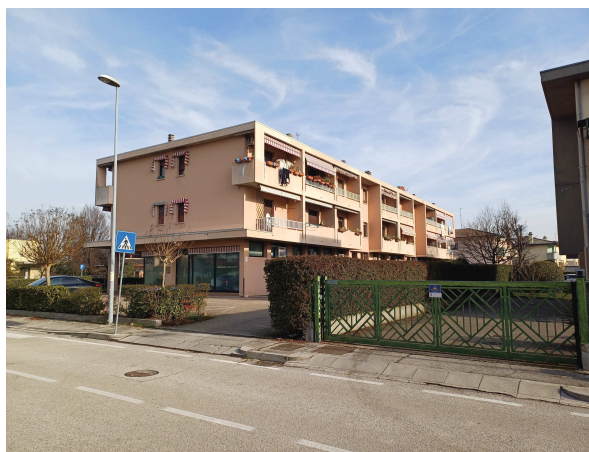
Prospetto sud da via M. Cengio
