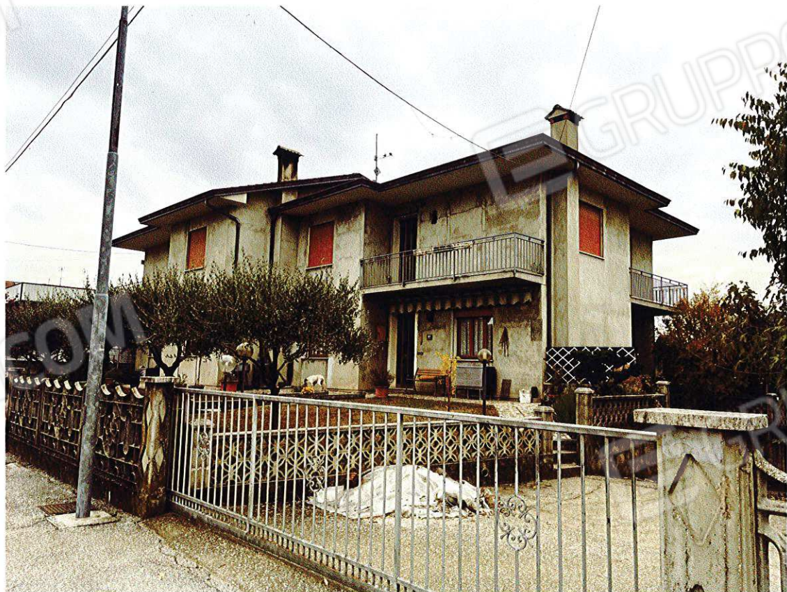
Fabbricato oggetto di E.I. - Vista sud - ovest
