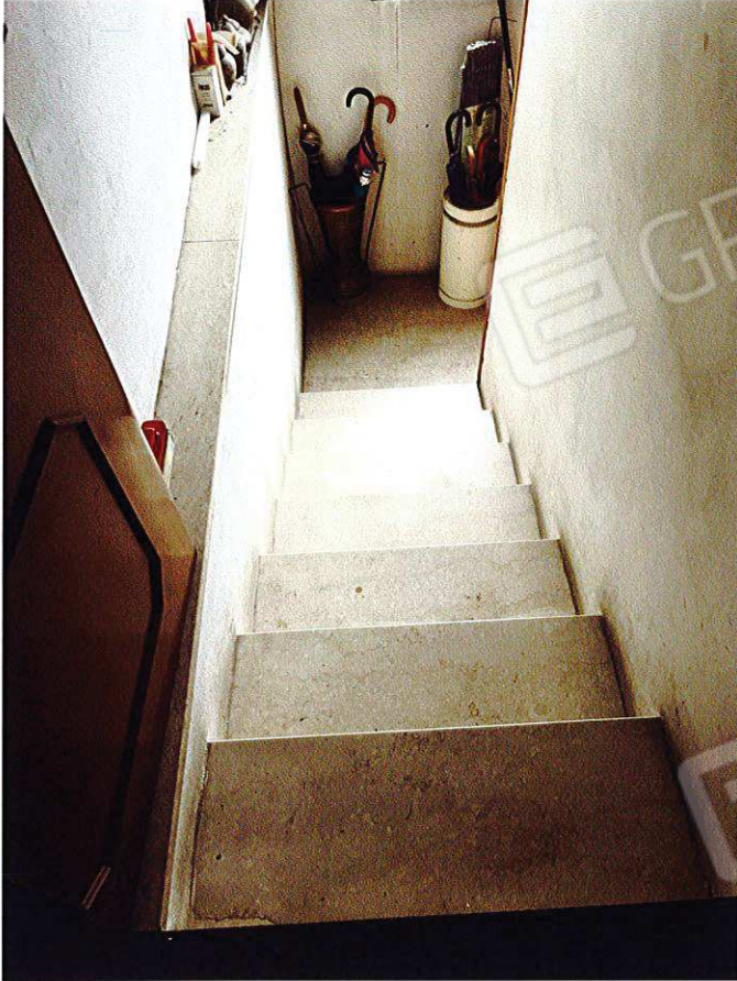
Scala al p. interrato
