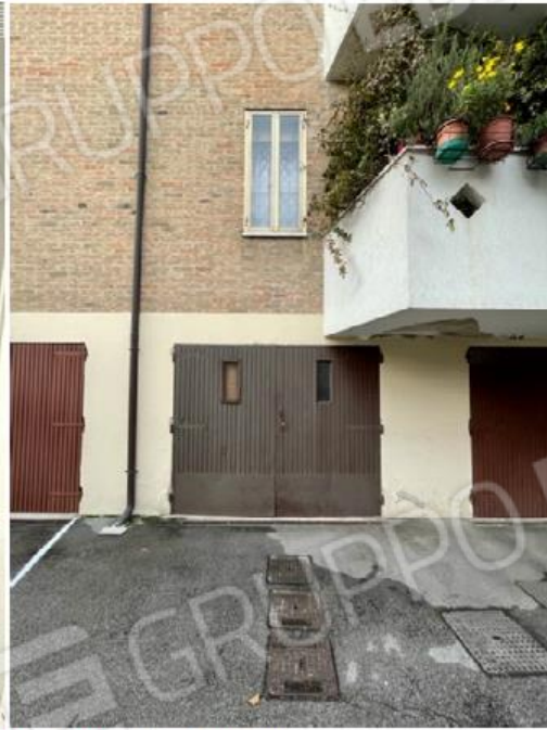
vista del basculante del garage
