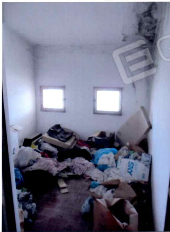
9 – Particolare d'interni: Soffitta
