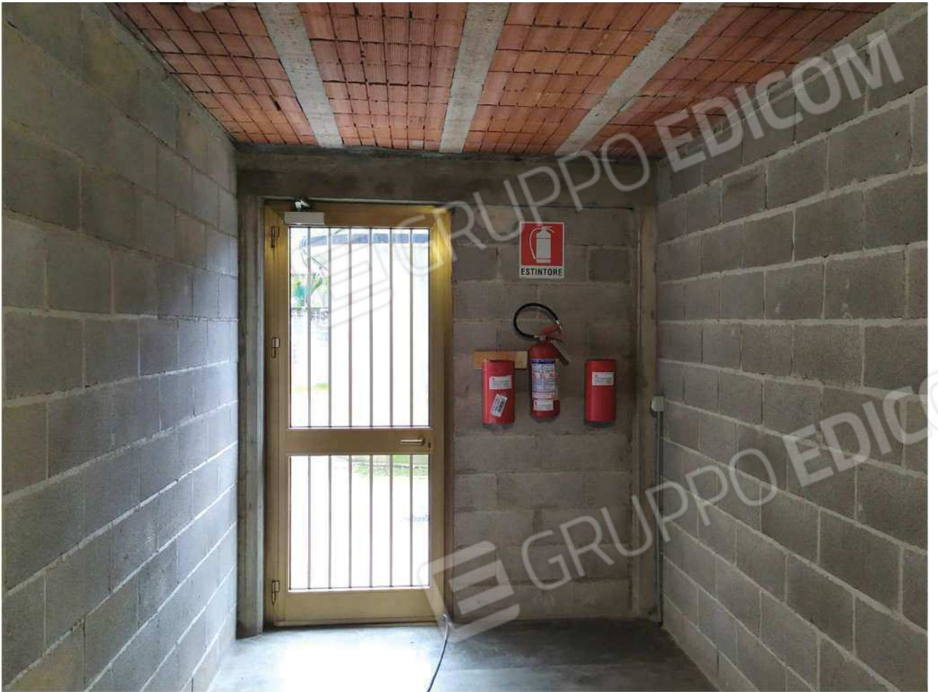
Corridoio condominiale al piano seminterrato
