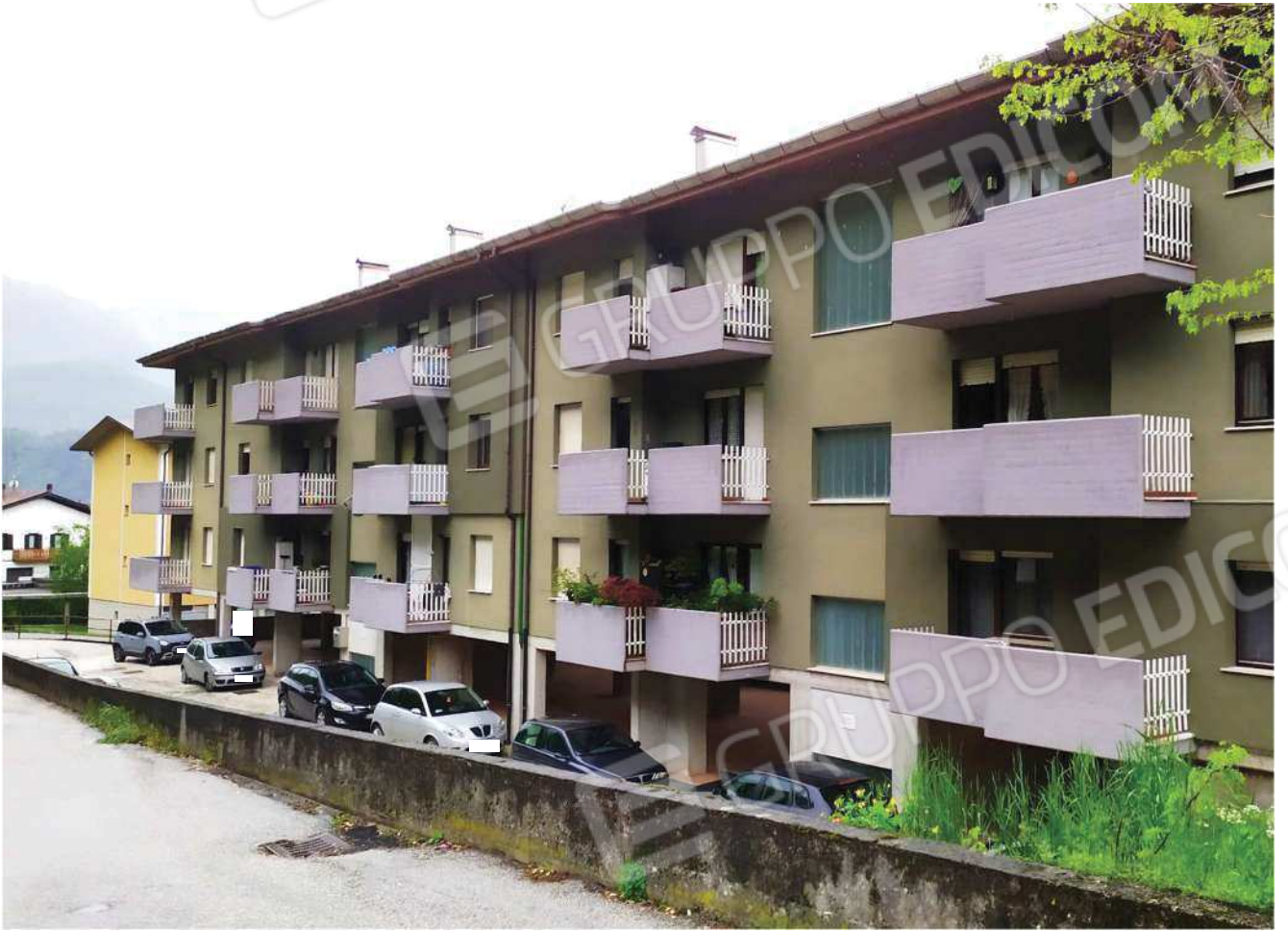
Veduta esterna del complesso condominiale
