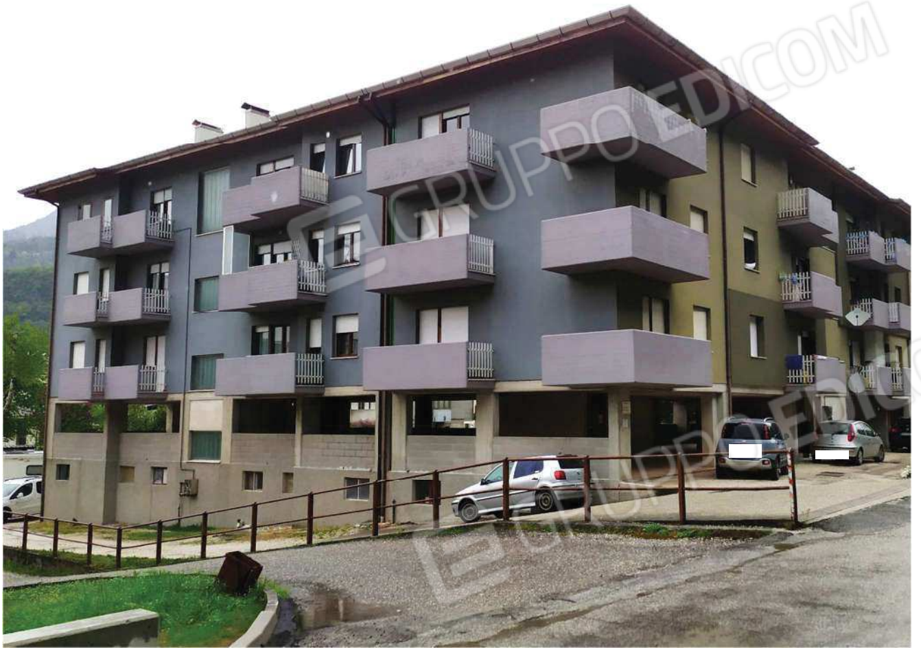
Veduta esterna del complesso condominiale
