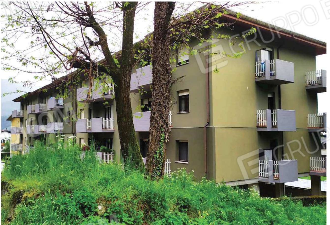
Veduta esterna del complesso condominiale
