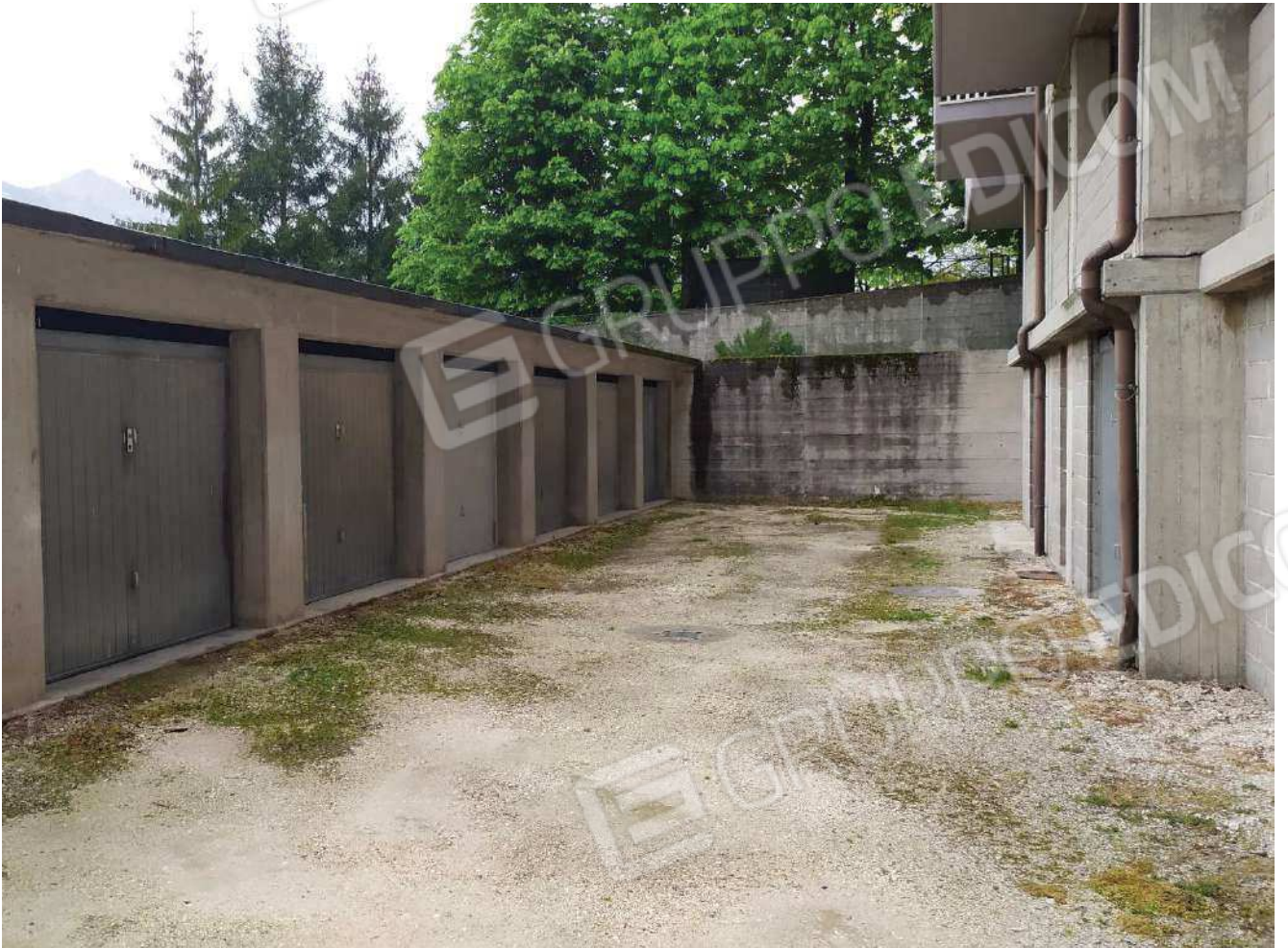
Area di manovra condominiale
