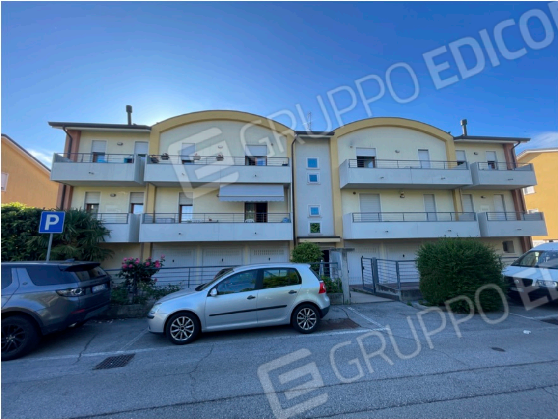
13 - Vista fabbricato lato est
