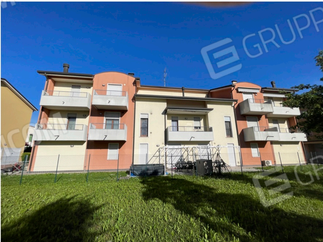
14 - Vista fabbricato lato ovest
