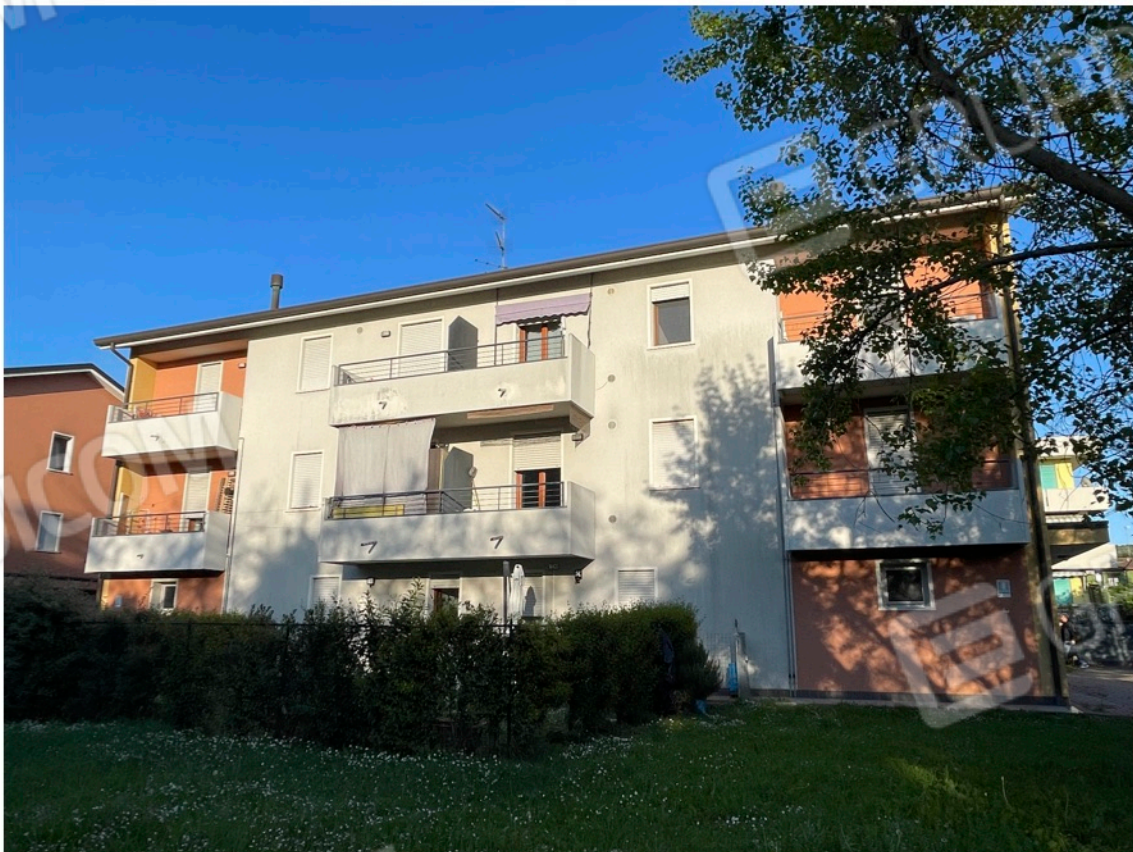
29 - Vista fabbricato lato ovest
