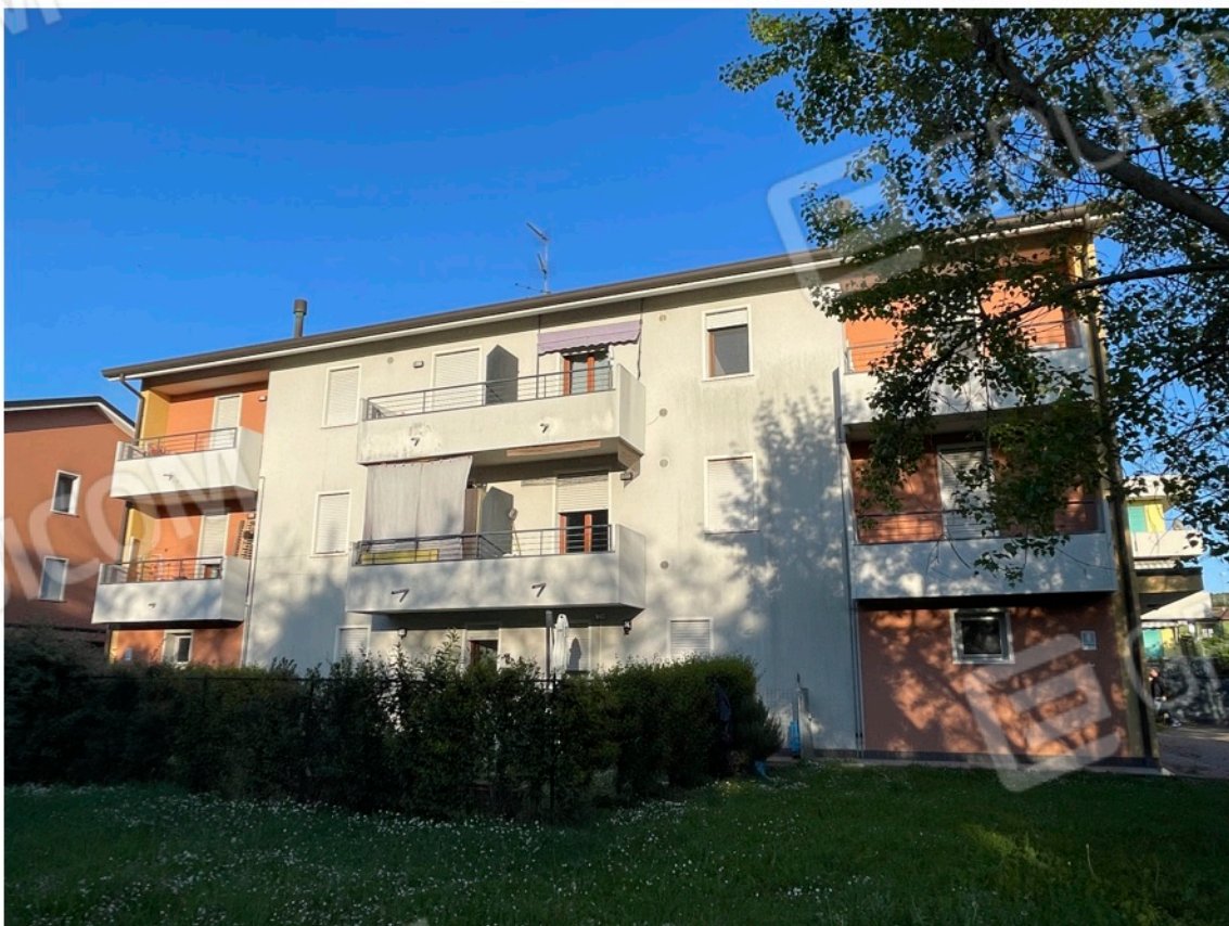
29 - Vista fabbricato lato ovest
