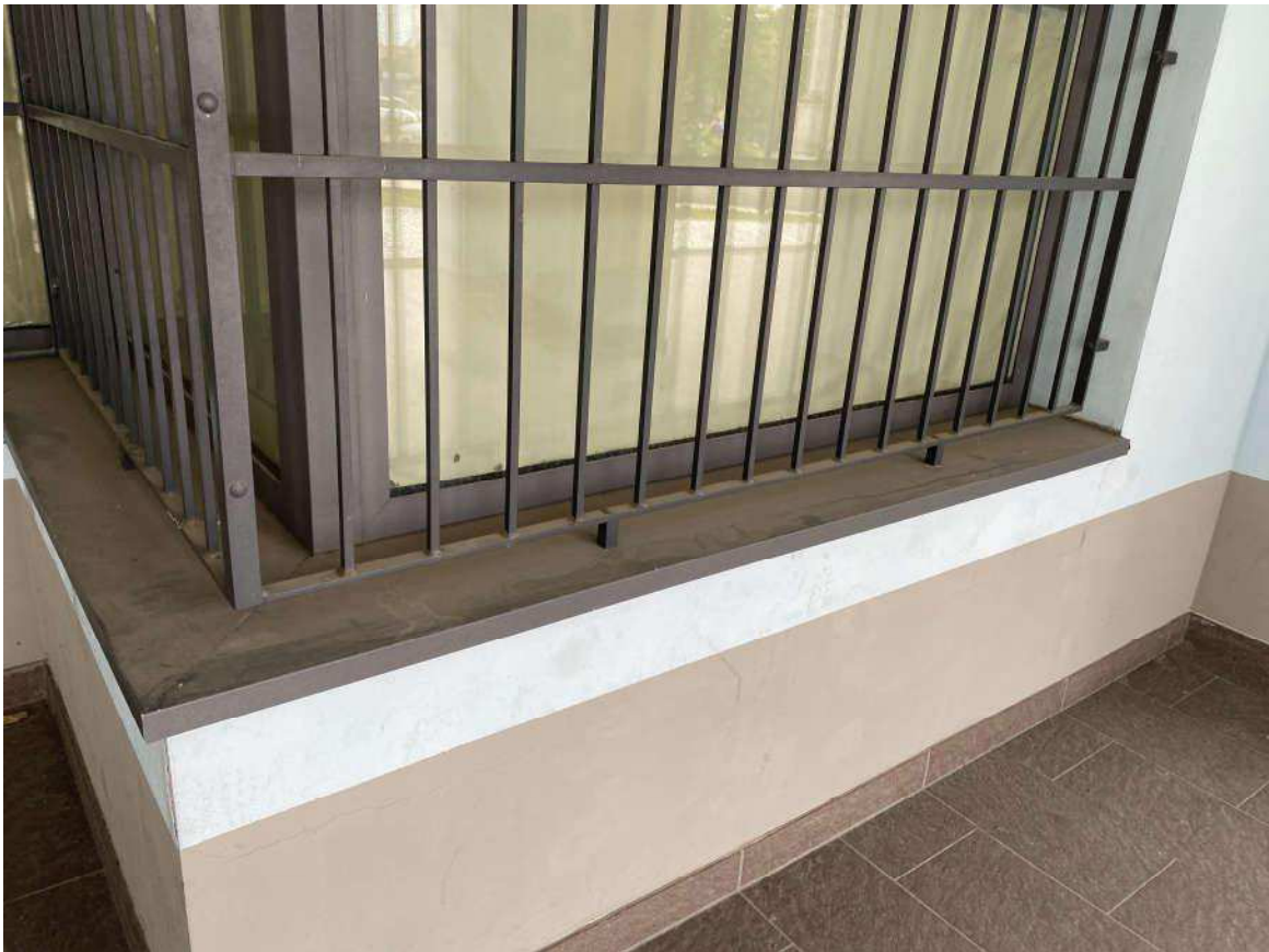
Foto 14 - particolare degli infissi
