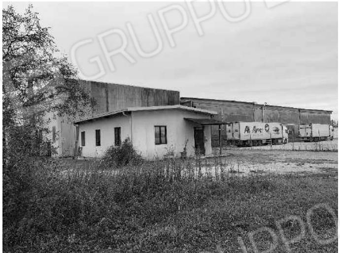
Foto 2 | Prospetto Sud - Est
