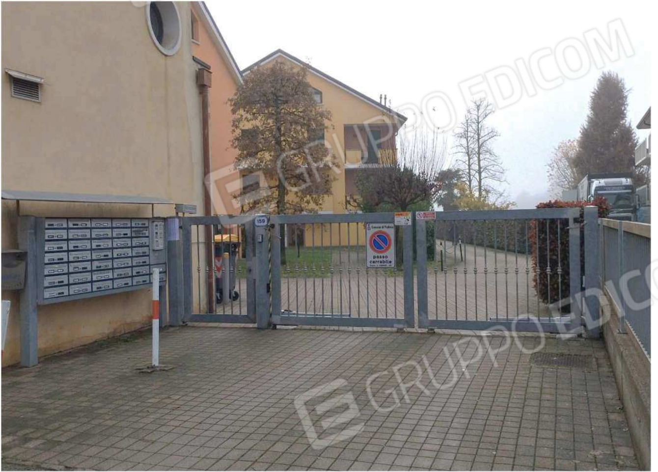
Veduta dell'ingresso pedonale e carroia
