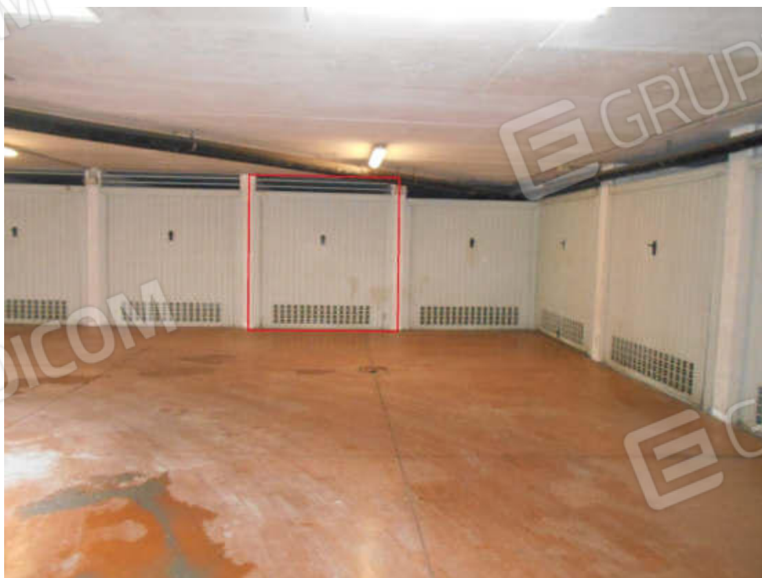
Foto 25: autorimessa interrata del compendio immobiliare, riquadrato in rosso il garage in oggetto
