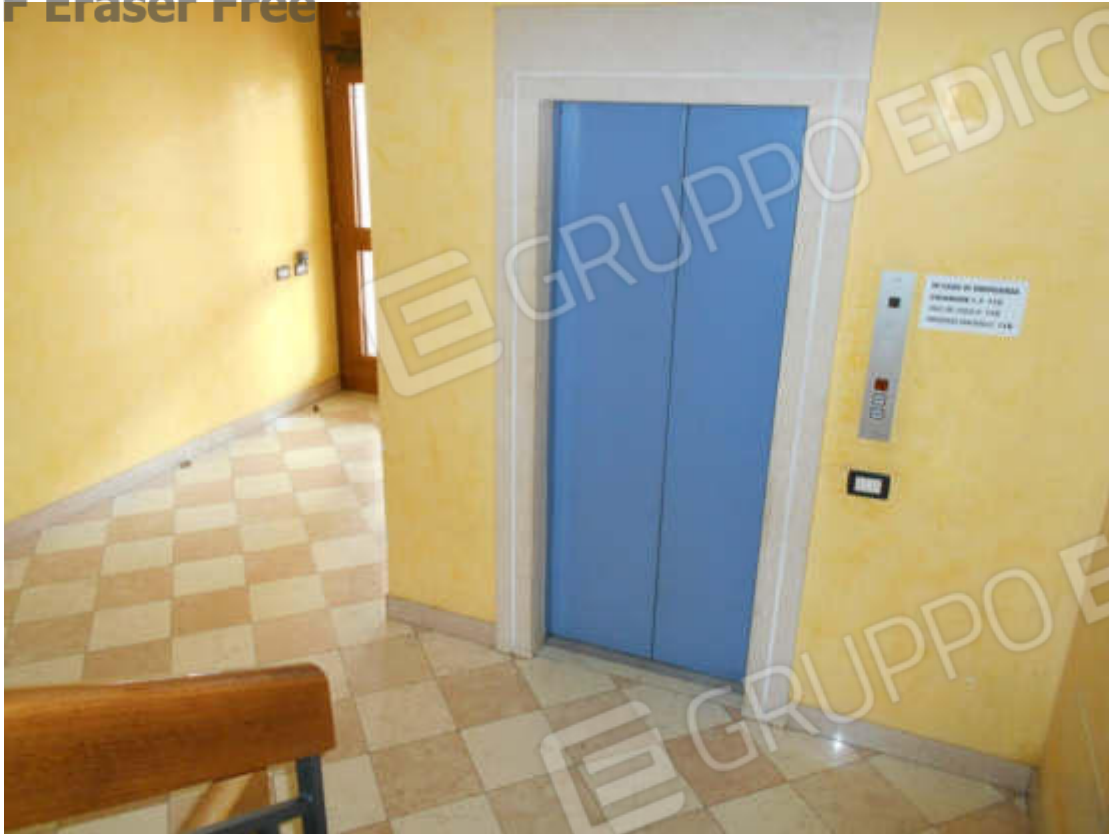
Foto 6: vano scala condominiale, piano terra
