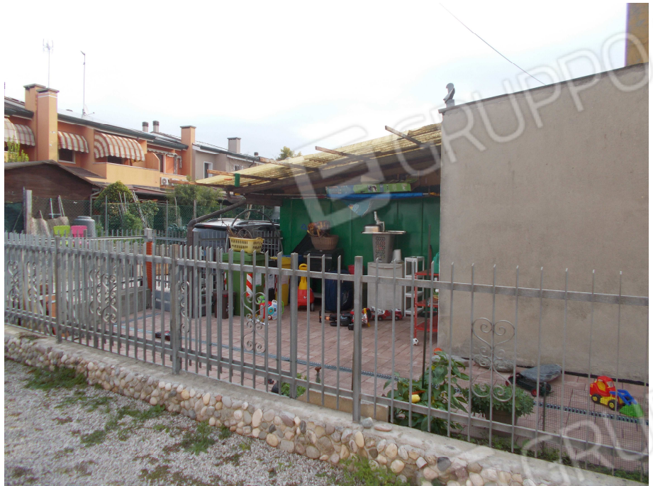
Foto 4- Vista cortile/retro da ovest
