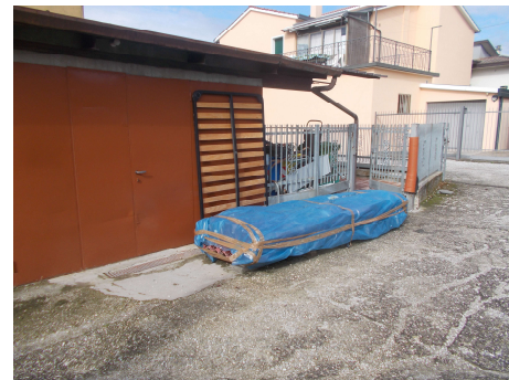
foto della tettoia sul retro - lastre in eternit
