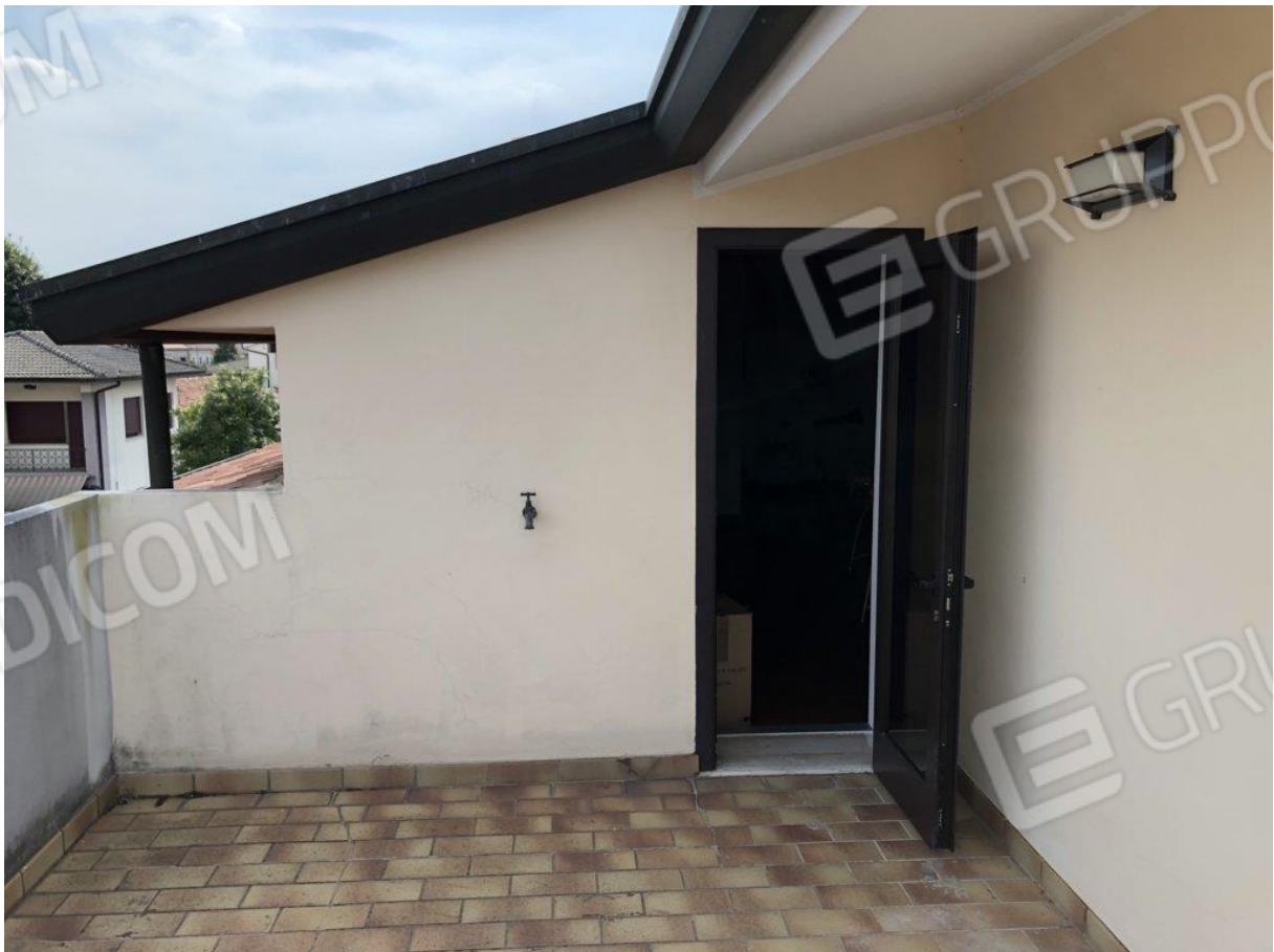
foto n. 22 – terrazza a piano secondo
