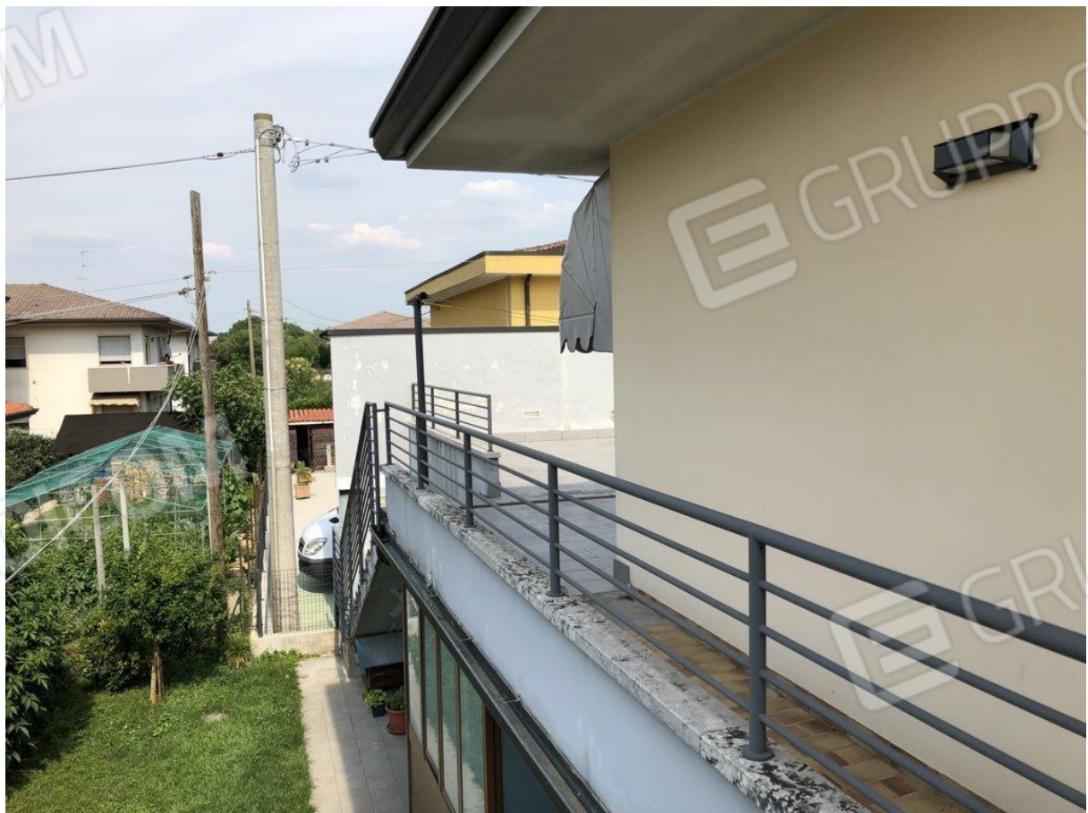
foto n. 18 – poggiolo piano primo lato nord
