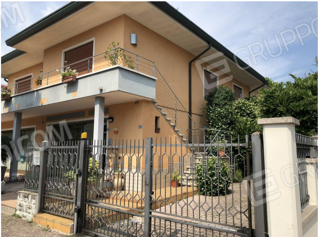
foto n. 2 – angolo sud-ovest del fabbricato
