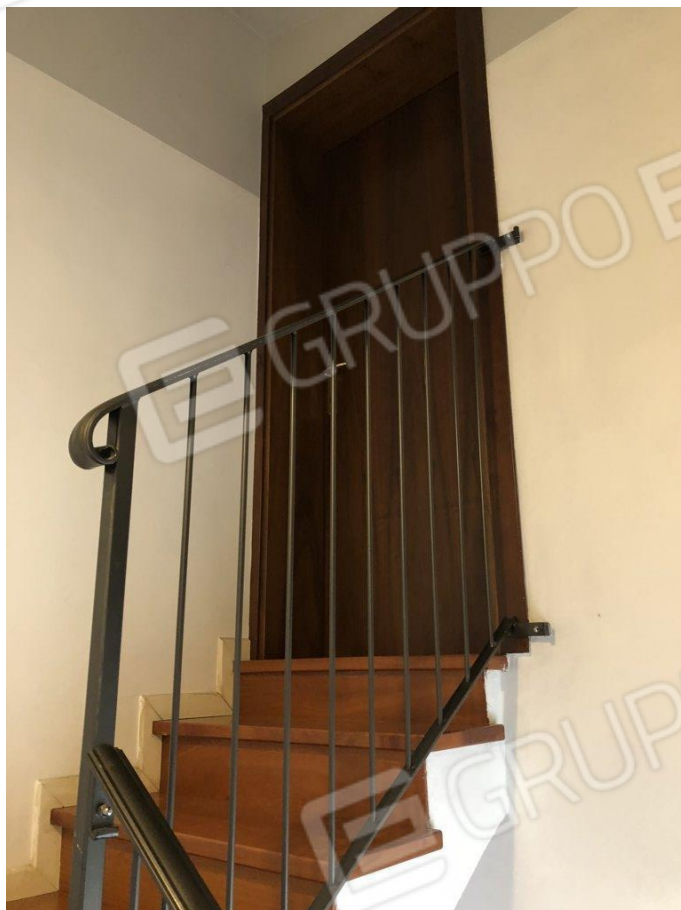
foto n. 19 – scala da piano primo a piano secondo
