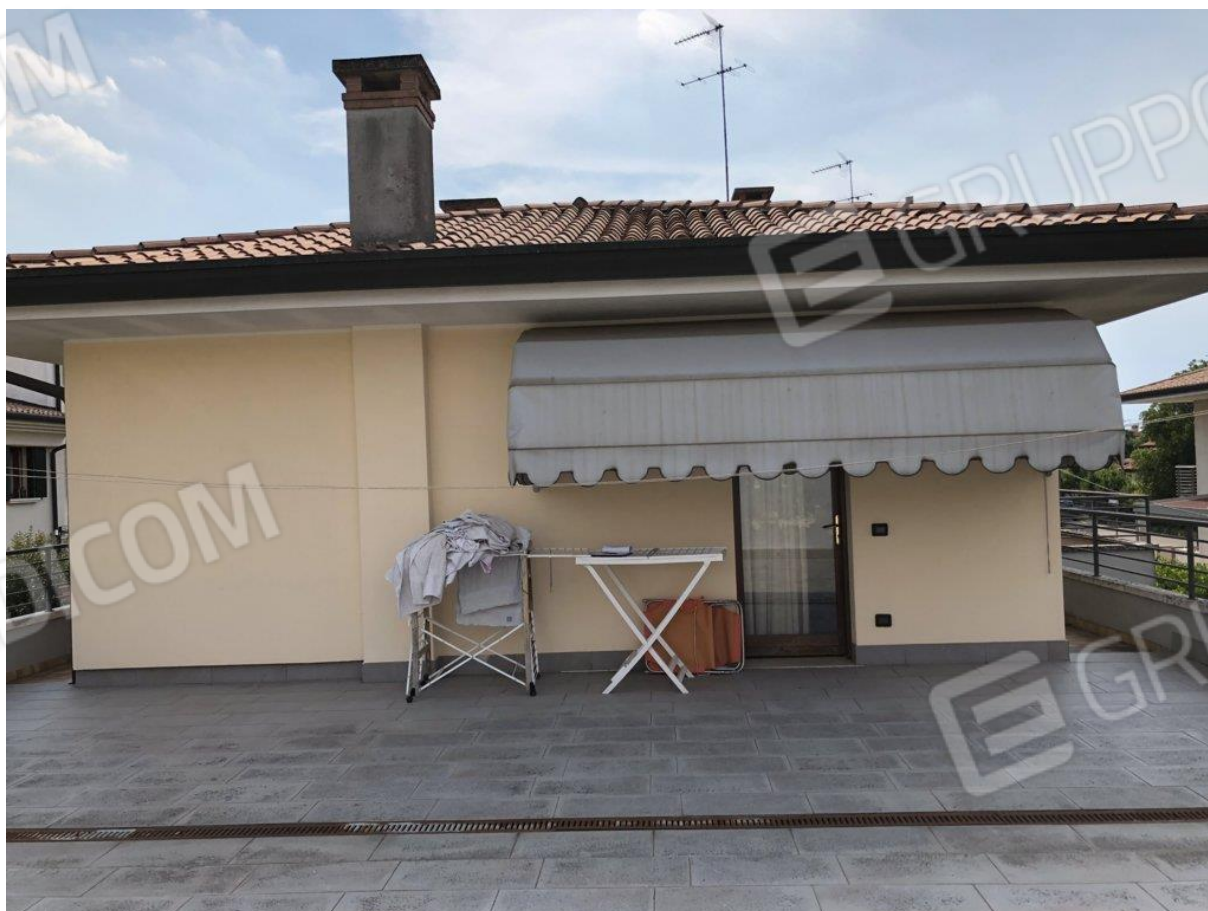
foto n. 16 – terrazza a piano primo
