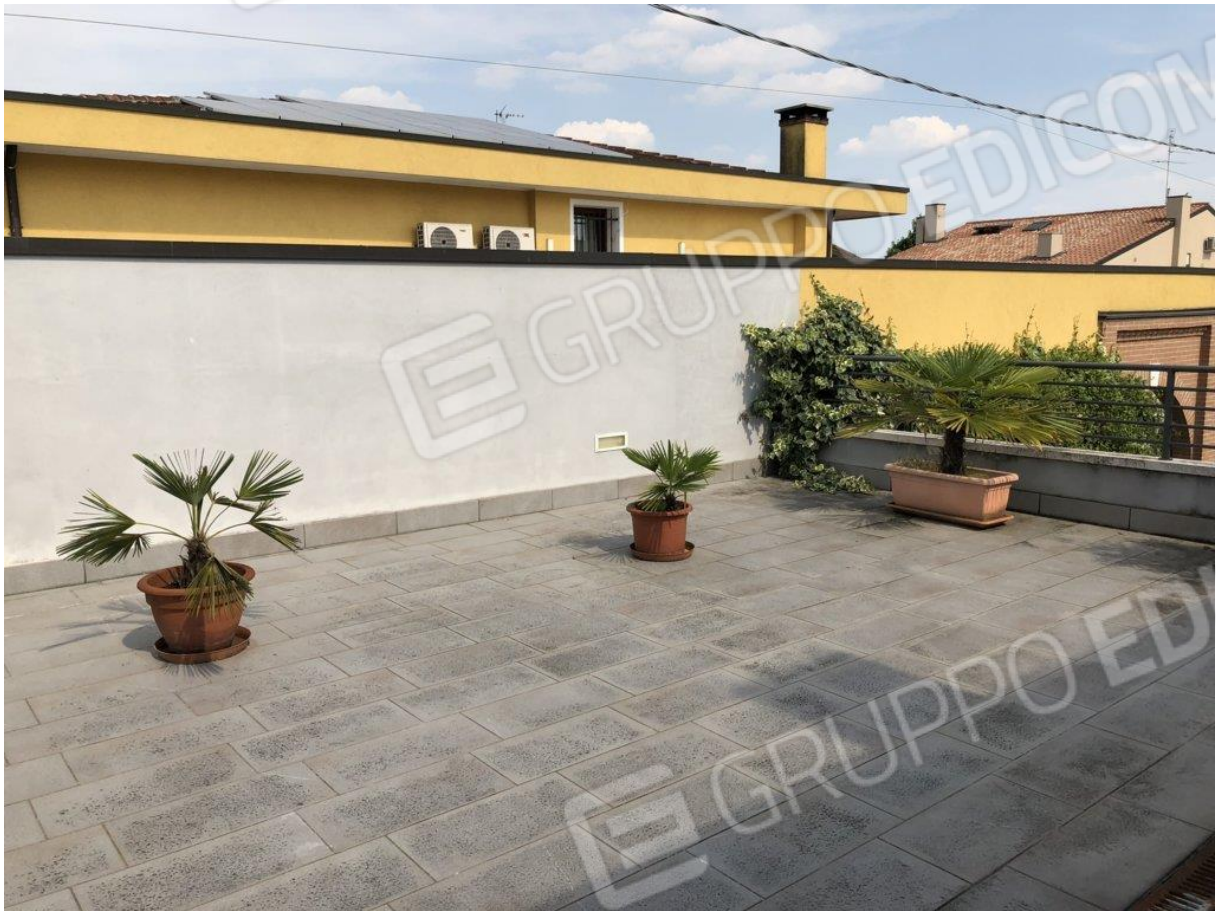
foto n. 17 – terrazza a piano primo
