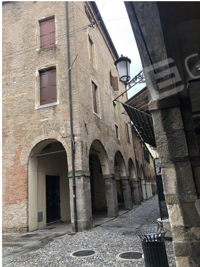
foto n. 2 – angolo nord-ovest con via Boccalerie
