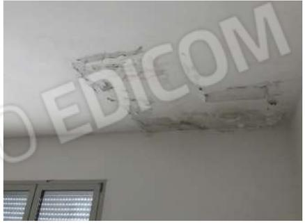
Foto 8-9 Appartamento Sub. 12: bagno e particolare infiltrazione
