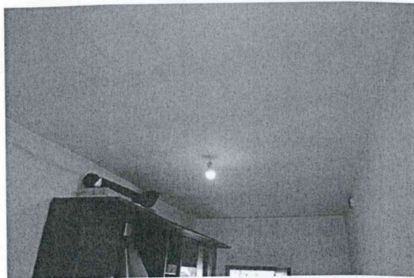
19 – Interno abitazione. Anche le "bruciate" di condensa intradossali depongono a favore dell'ipotesi di solaio in laterocemento tra pianterreno (abitazione) e primo piano (legnaia).
