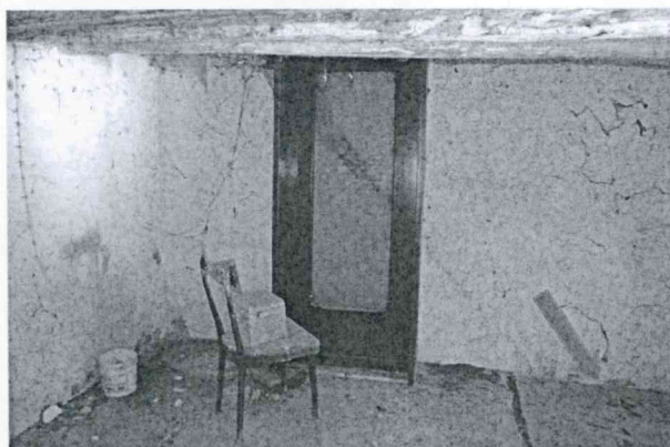
13 – Soffitta. Una porta pare murata in breccia nel divisorio tra il m.n. 113 e il m.n. 164. La freccia blu indica un angolo di tavolato pavimentato in tavelloni, verosimilmente a chiusura del vecchio sbarco di una scala dismessa.
