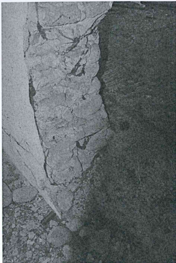
11 – Soffitta. La rudimentale breccia praticata nella muratura di passaggio permette di osservare la tessitura dei paramenti, laddove una larga predominanza di ortostati in pietra naturale è abbinata a sporadici diatoni in laterizio alla lunga.
