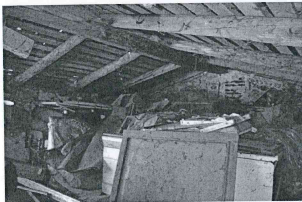
7 – Legnaia al primo piano. Dove la copertura del corpo di fabbrica sud (brolo) si innesta sul tetto del caseggiato a schiera, una trave di colmo regge le spioventi appoggiandosi al muro in comune col m.n. 148 e sbarcando sull'ultimo corrente dell'ordito maggiore.
