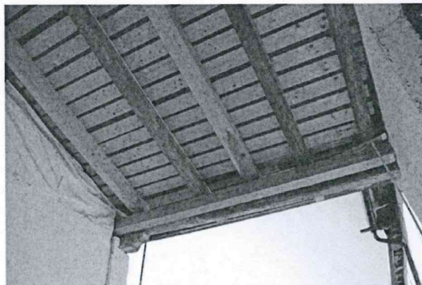
14 – Portico d'ingresso. L'esecutato ha provveduto in proprio al rifacimento dell'ordito e del tavolato tesi sopra la tettoia d'arrivo dal vialetto d'ingresso. L'intervento è privo dei supporti documentali e progettuali di genio civile (calcoli, disegni, schede dei materiali).
