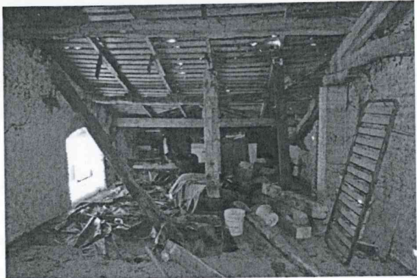
6 – Legnaia al primo piano. La falda sud, avente superficie indicativamente doppia rispetto alla falda nord, mostra gli stessi caratteri costitutivi del resto dell'ordito. Ben visibili buchi, inflessioni e addirittura puntellature in falso.
