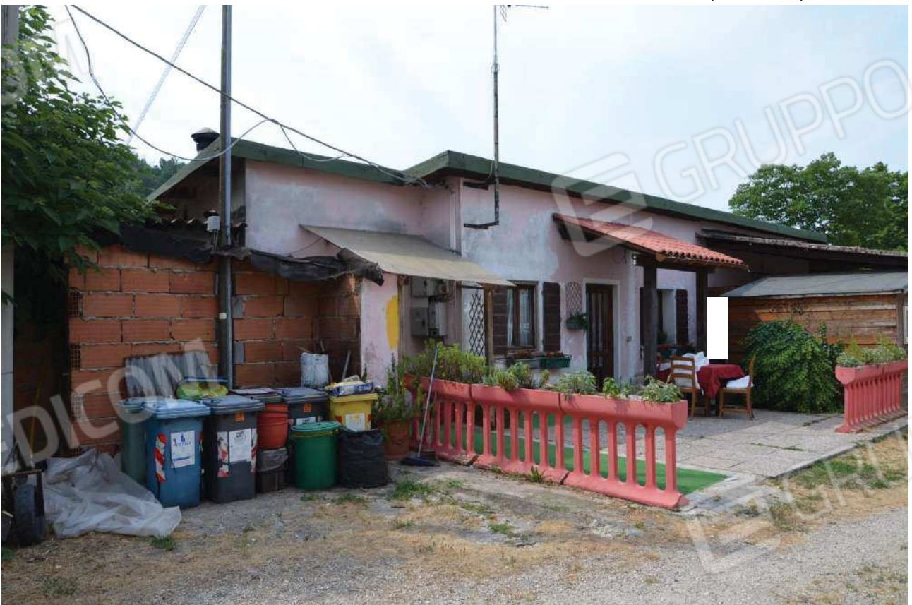
Prospetto sud porzione est
