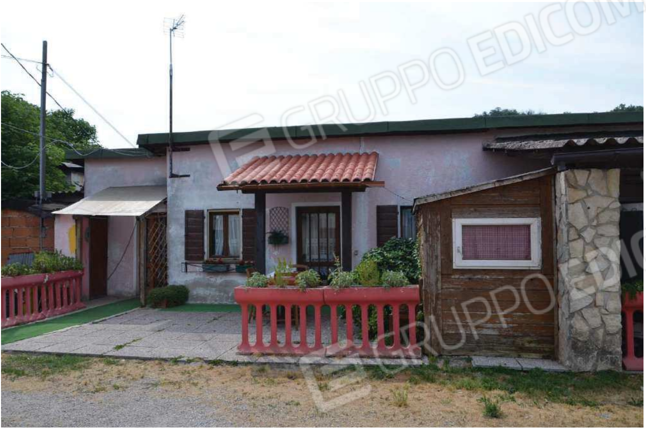
Prospetto sud porzione est
