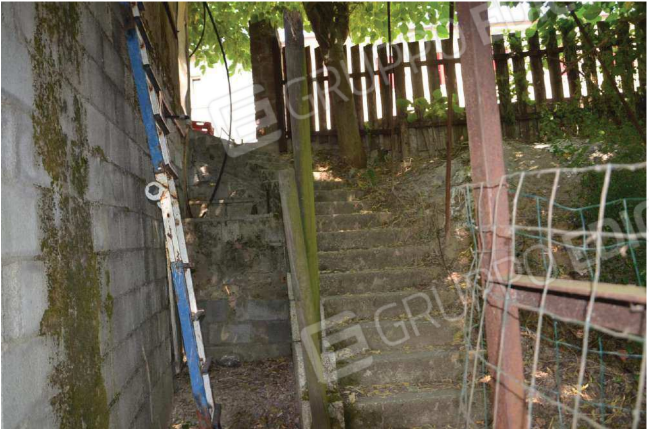
Scala di accesso al piano superiore – lato est
