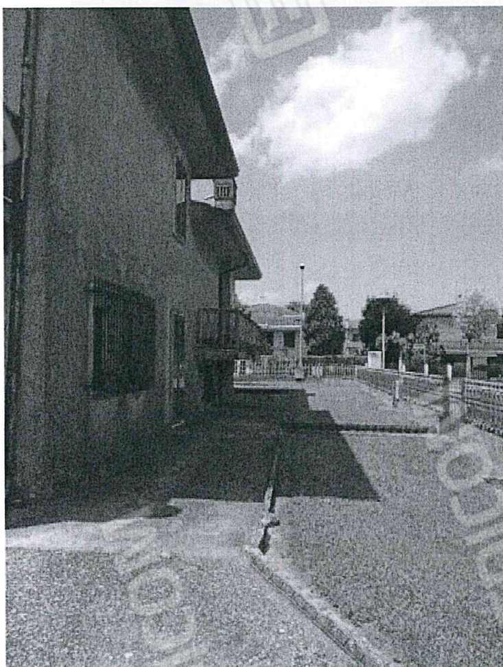
Foto 4: cortile pertinenziale, porzione nord
