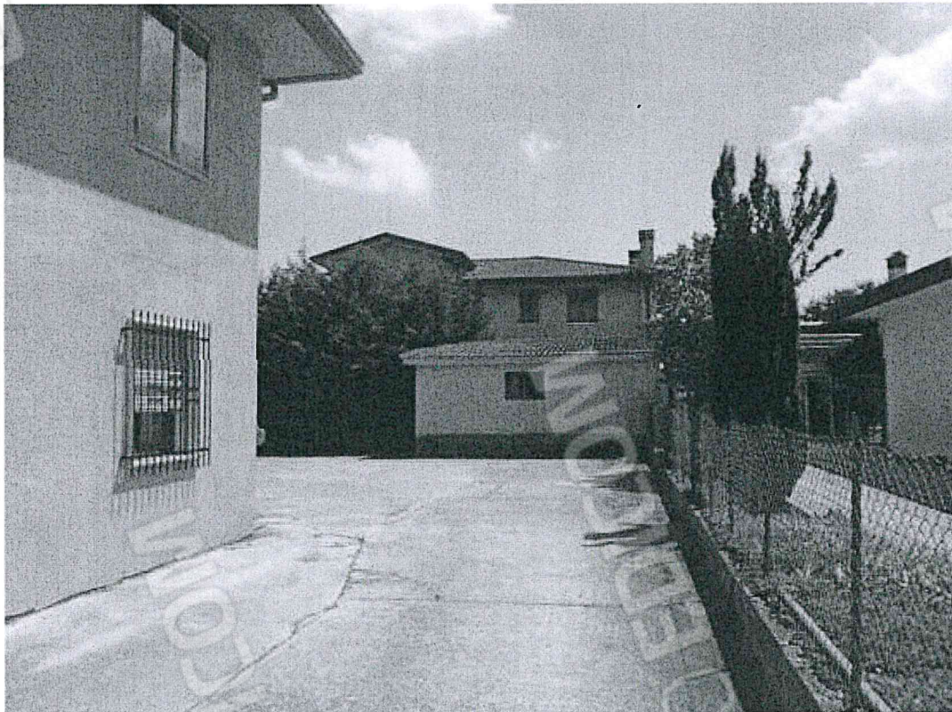
Foto 14: corpo di fabbrica a garage
