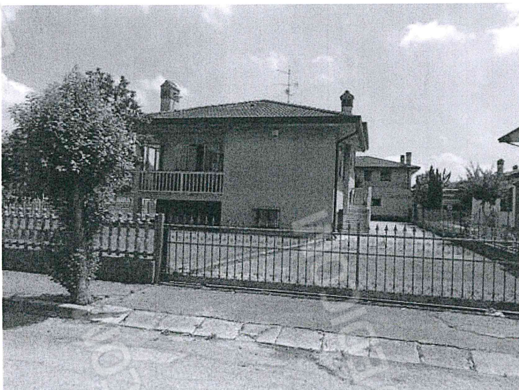
Foto 8: prospetto ovest, da via De Gasperi
