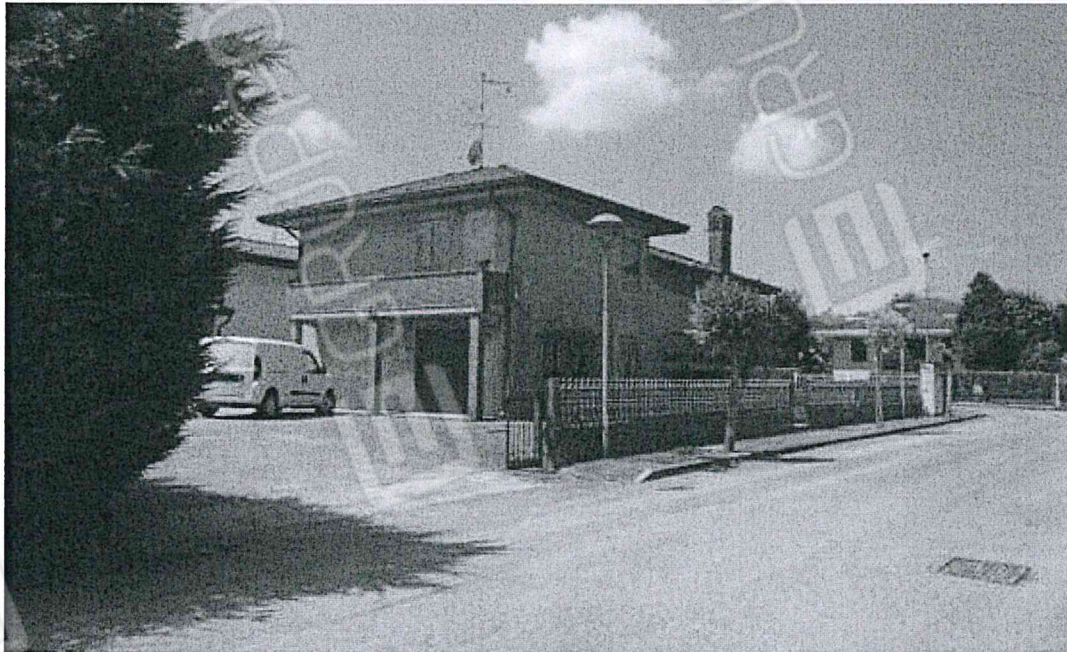
Foto 1: Abitazione vista da via Mingoni
