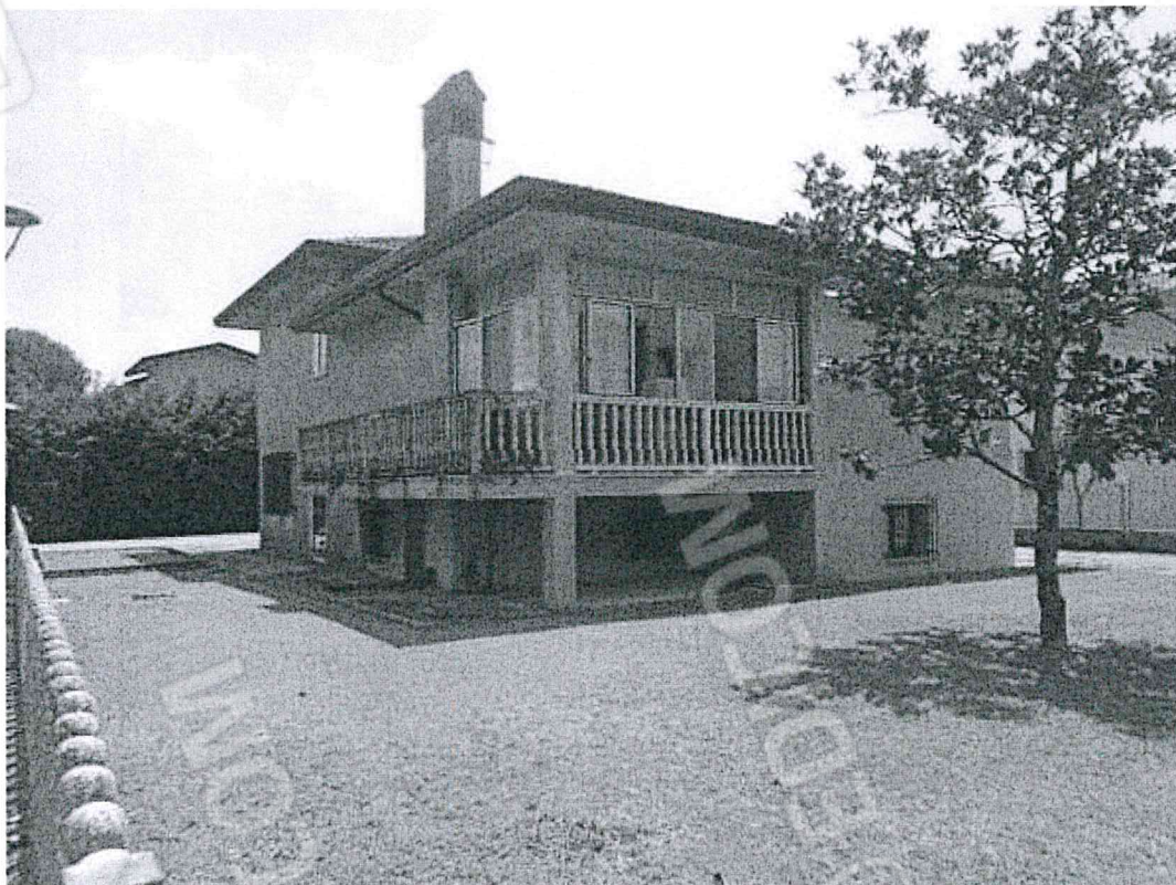
Foto 6: prospetti nord ed ovest dell'abitazione, cortile pertinenziale
