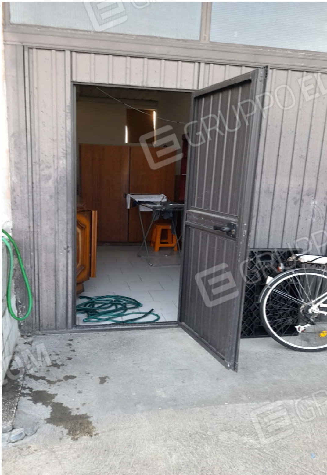
IMG 04 – FACCIATA OVEST MAGAZZINO
