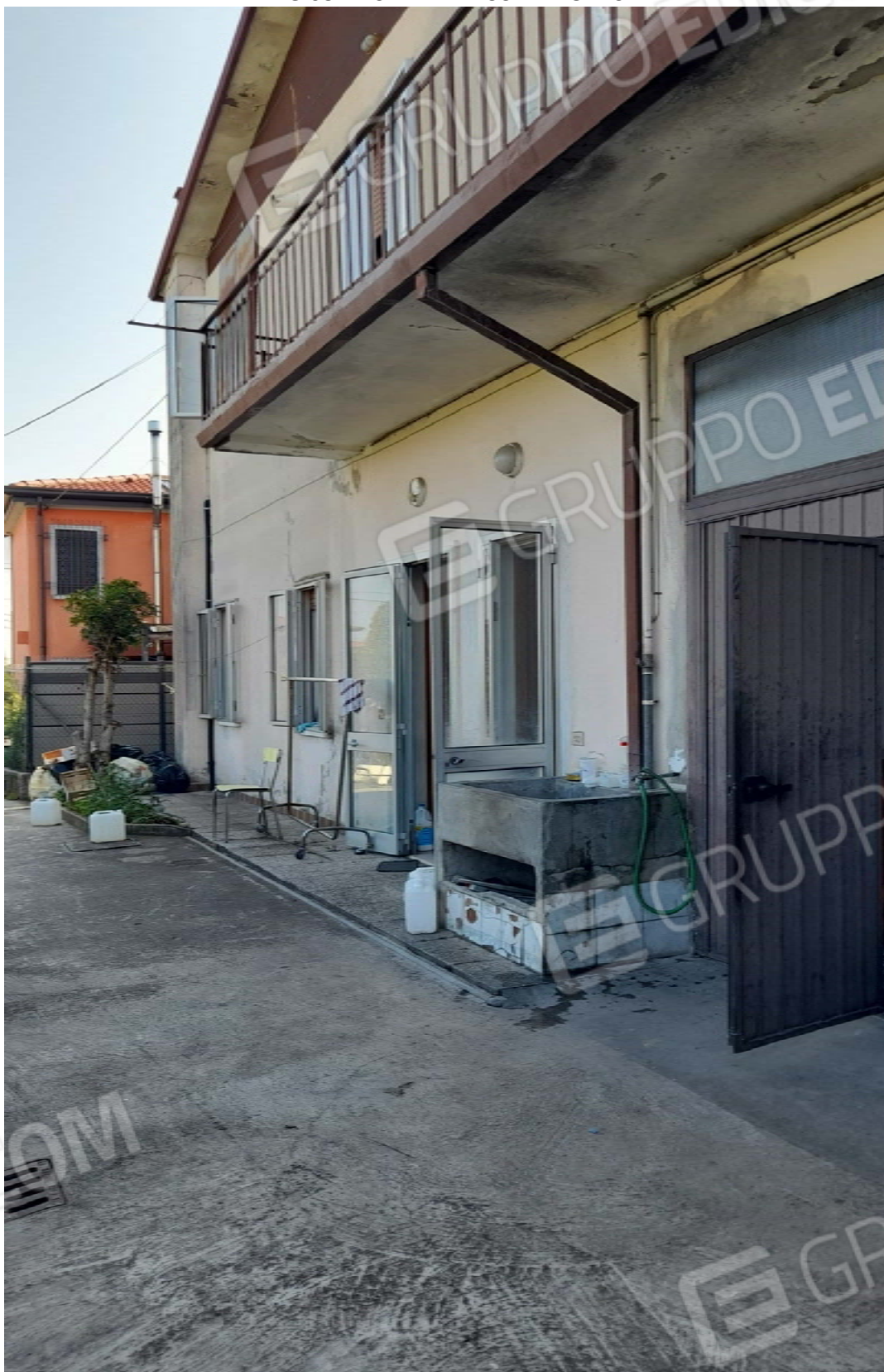
IMG 03 – ESTERNI FACCIATA OVEST
