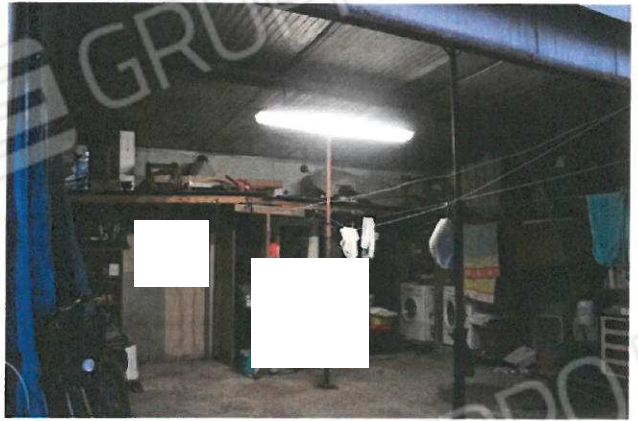
4 – Deposito/ripostiglio da demolire
