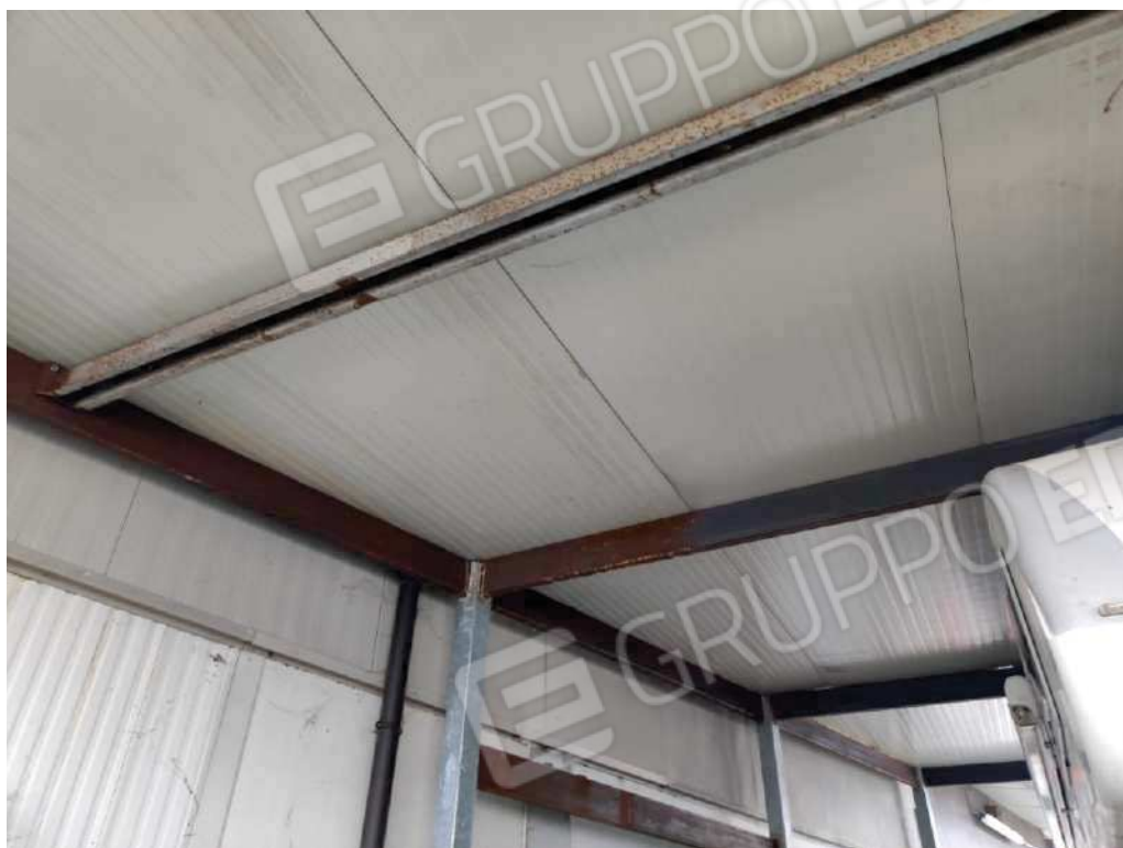
FOTO N. 49 (porzioni da demolire)
