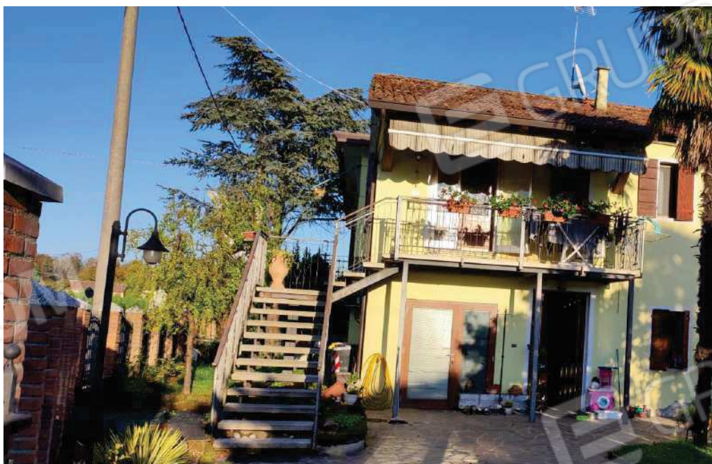
FOTO N. 28 (alloggio piano primo)
