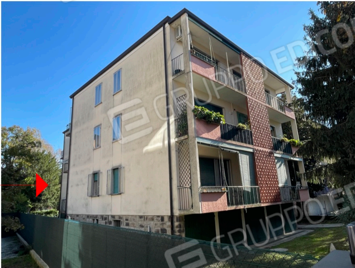
4 - Vista del fabbricato lato strada
